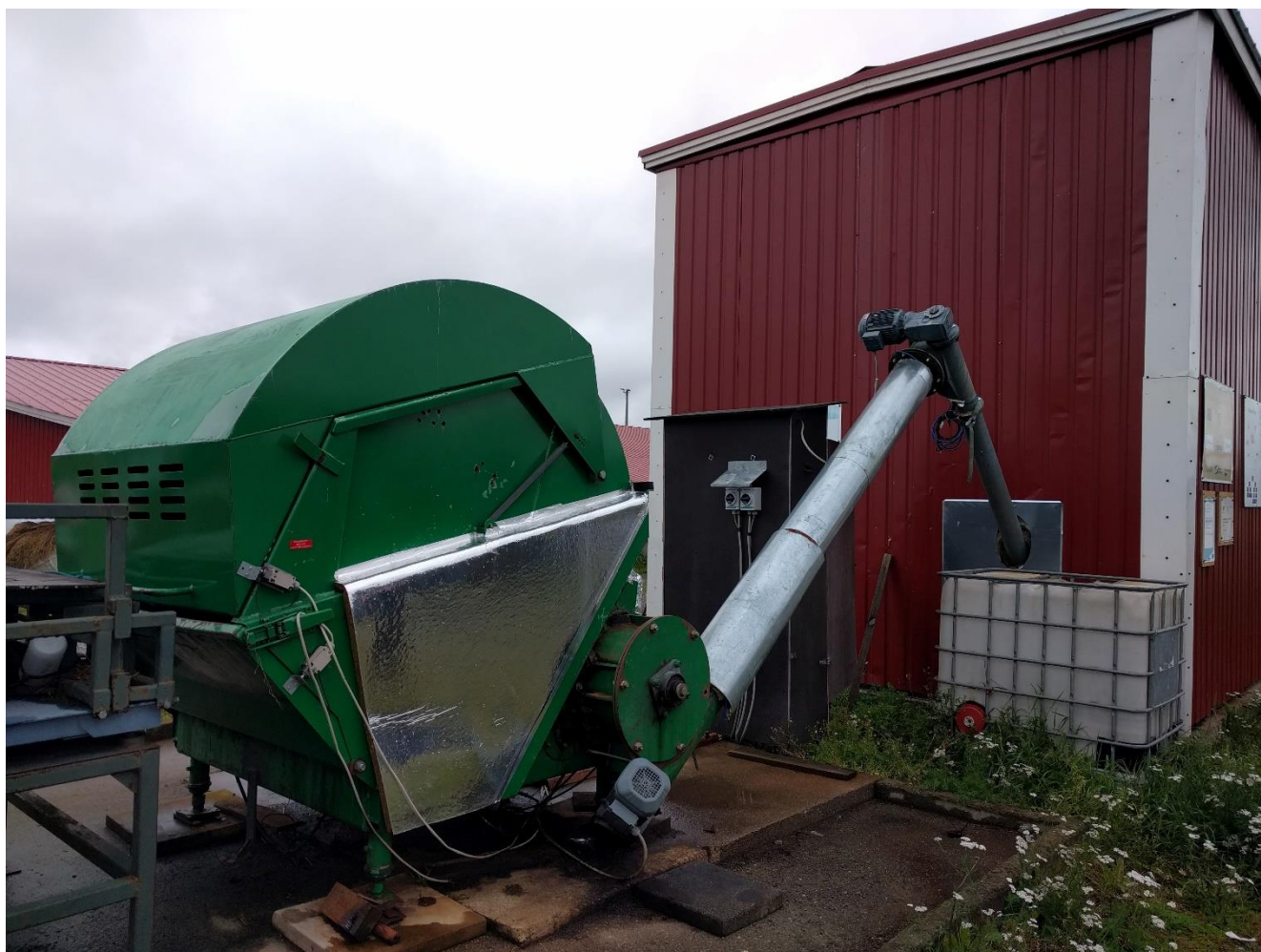
Kuva JEDU Haapajärven biokaasulaitoksesta. Edessä näkyvä laite on lisäyöteyksikkö, josta johdetaan putki taustalla olevaan reaktorirakennukseen.
