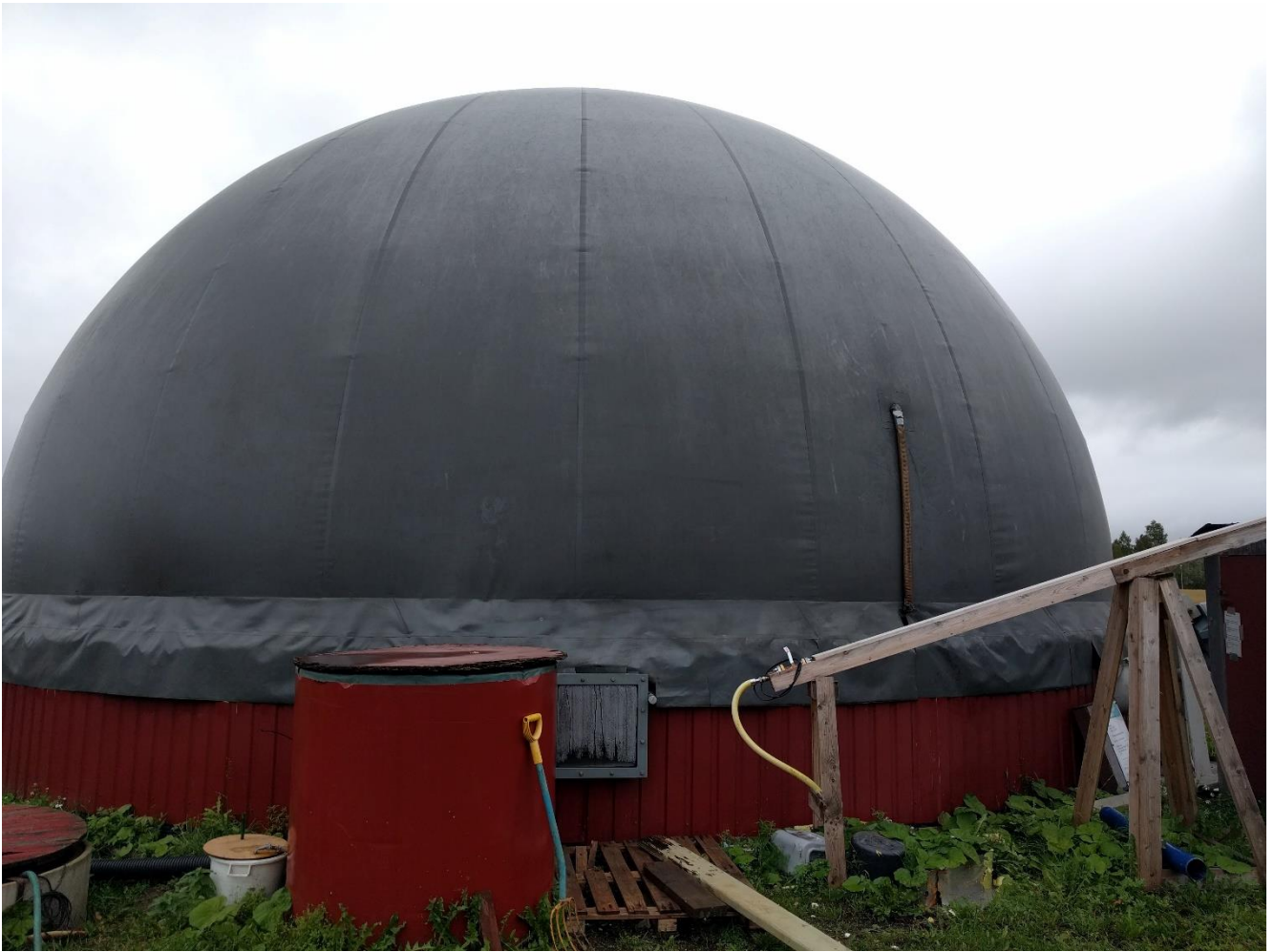
Kuva biokaasulaitoksen jälkimädätysaltaasta ja kaasuhupusta.
