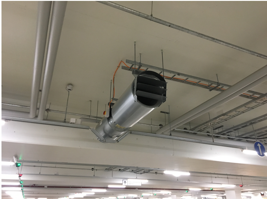
KUVA 6. Suuntapainepuhallin asennettuna
