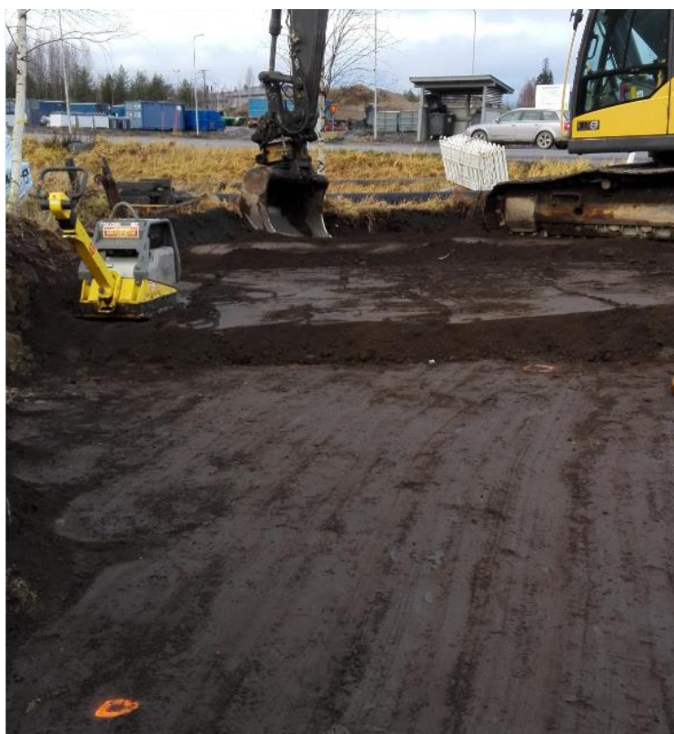
KUVA 5.3. 3. koerakenteen lentotuhkakerros tiivistettynä (Tuunainen 2018-11-14)
