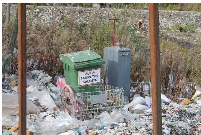
Kuva 15. Alkusammutuskalustolle on oltava esteetön kulku, jotta välineet ovat helposti käyttöönotettavissa tulipalotilanteessa
