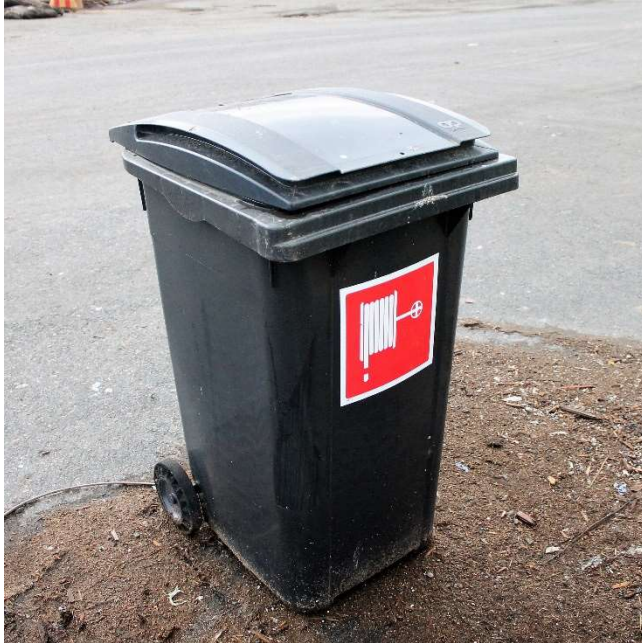
Kuva 14a. Jätekkuko Oy:n jätekeskuksen alkusammutuskaluston sijoitus
