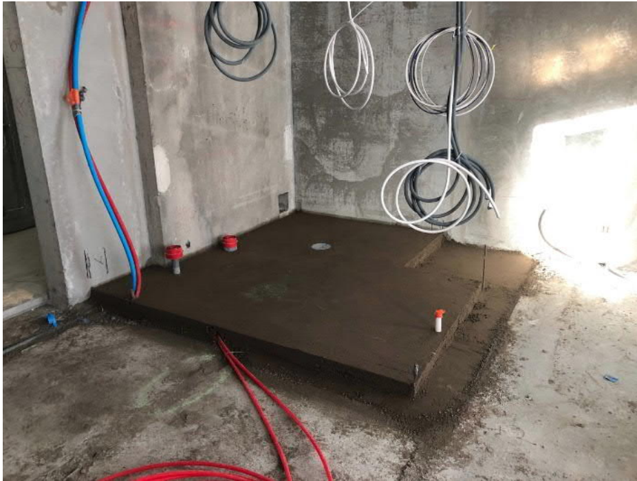
Kuva 10. Valmis maakostea betonilattia kylpyhuoneen kohdalla
