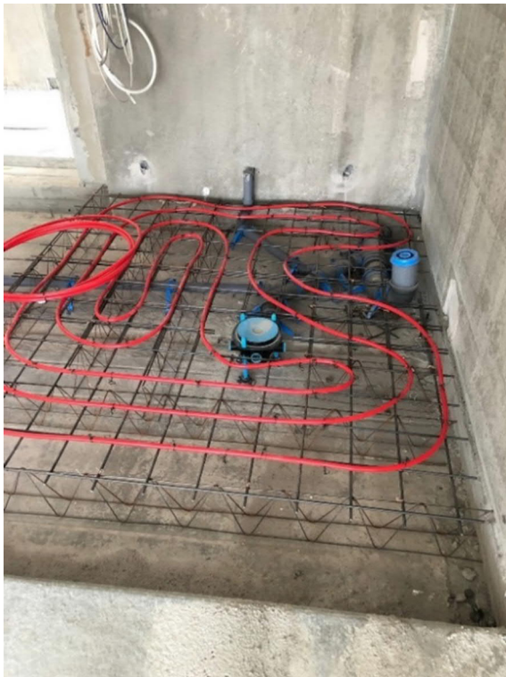
Kuva 7. Kylpyhuoneen lattiarauditus ja lattialämmitysputket
