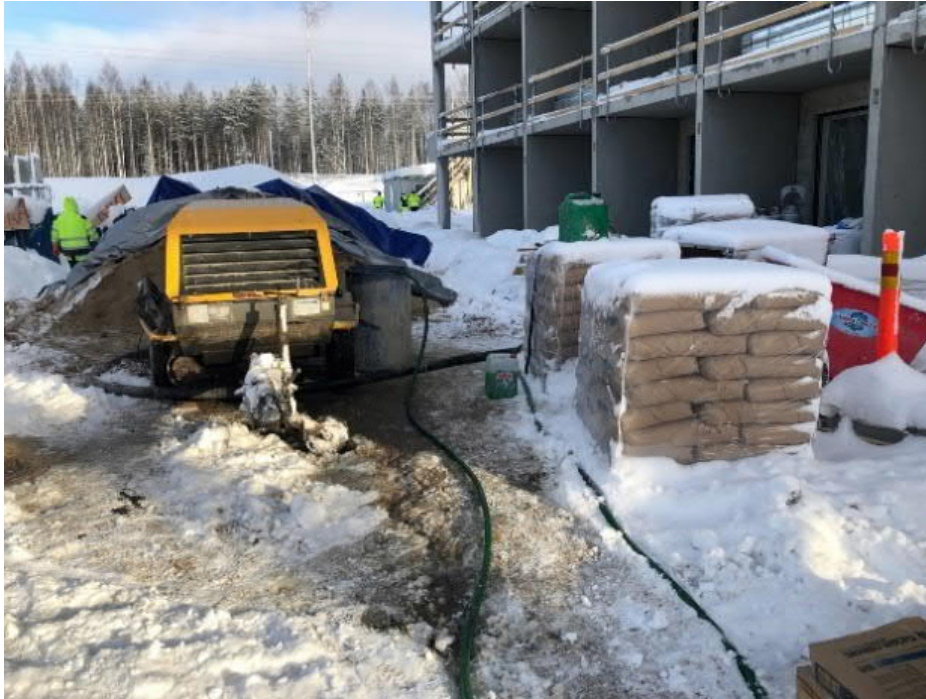
Kuva 5. Betonipumppu ja sementtisäkit
