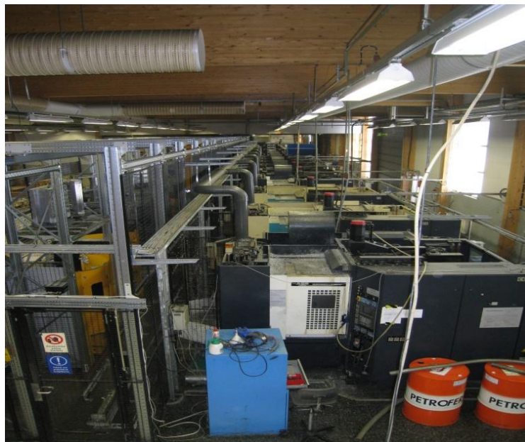
KUVIO 1. Nivalan tehtaan automaattikoneistuslinja.
