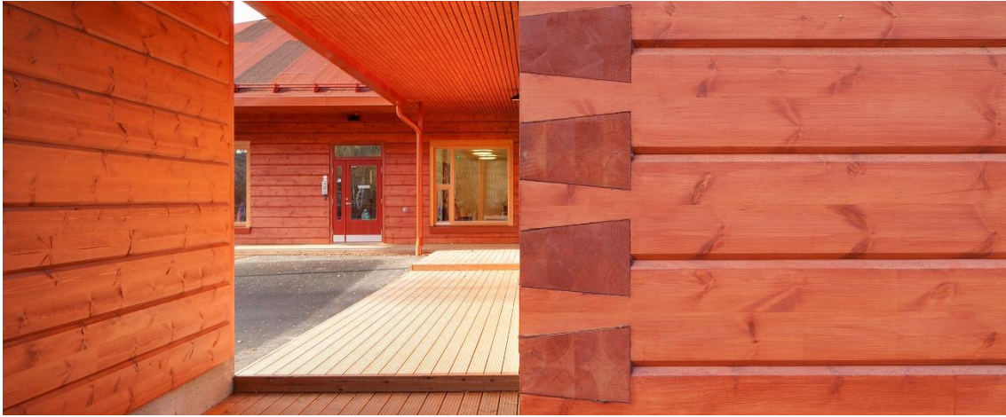
KUVA 4. Hirsinurkan yksityiskohta (Pihlajaniemi – Tervaoja 2013, 17)
