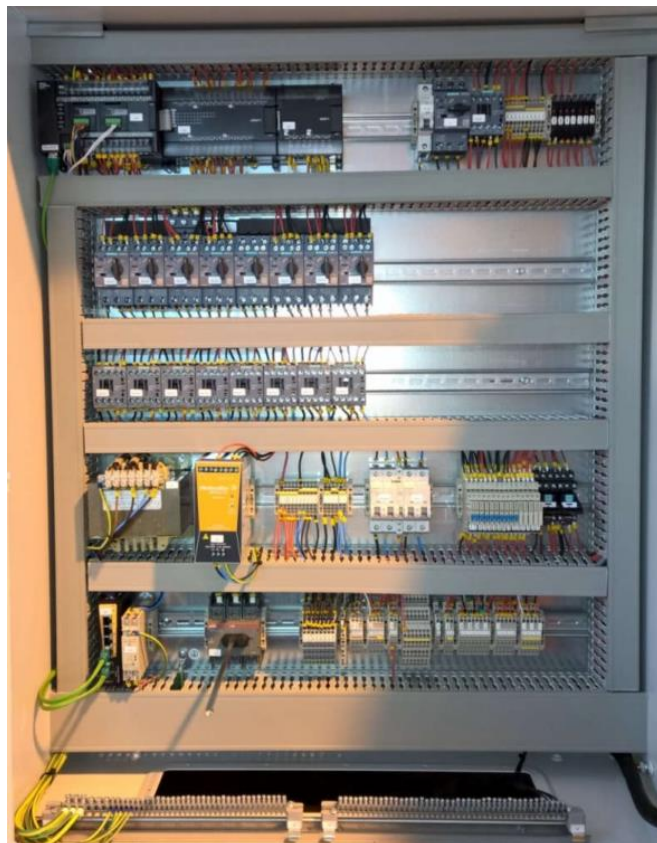
Kuva 7. Valmis ohjauskeskus ennen kenttälaitteiden kytkentää [23].
