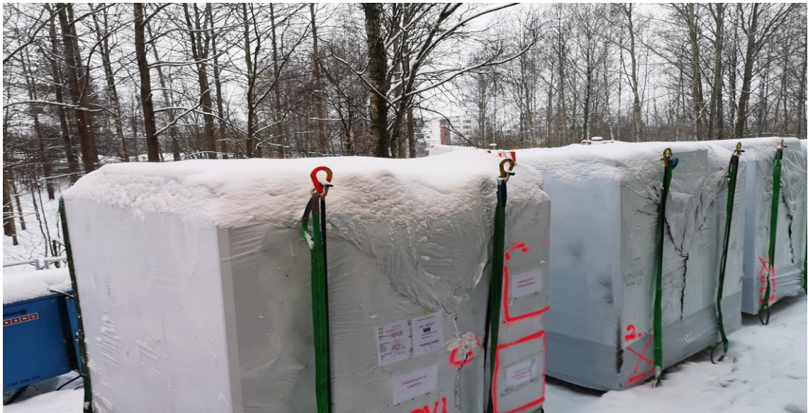
Kuva 12. Märkätilaelementit ovat saapuneet työmaalle. Elementit tarkistetaan vaurioiden osalta ja varmistetaan sääsuojaus
