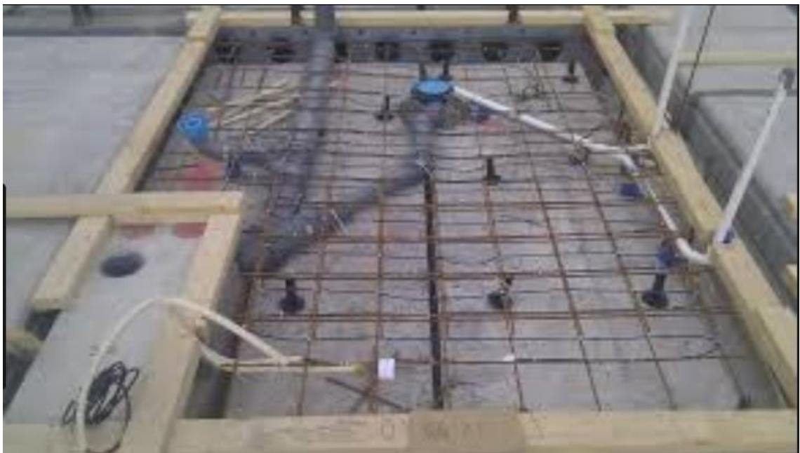
Kuva 9. Kaatovalu ennen väliseiniä
