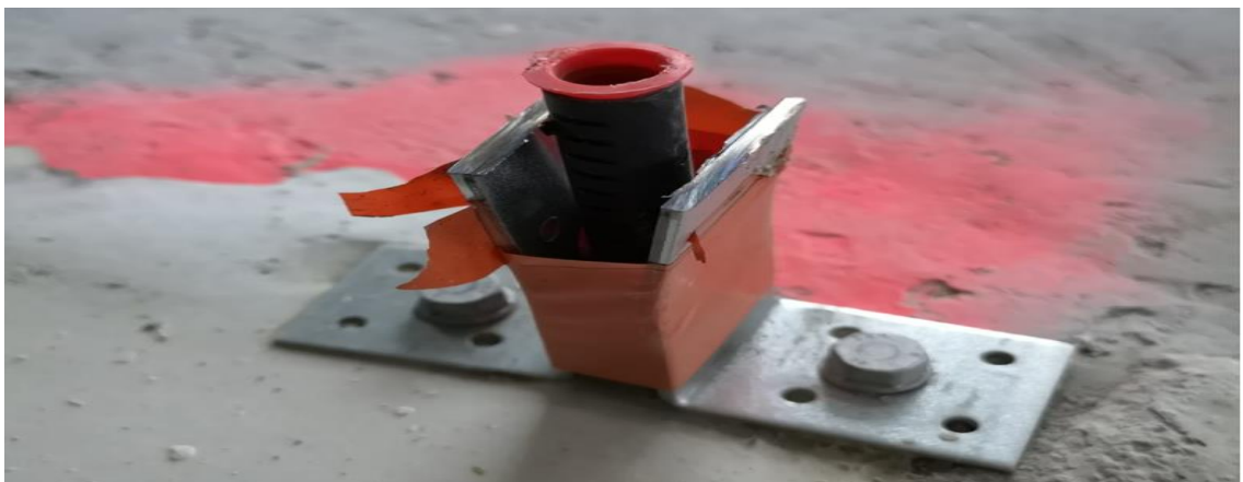
Kuva 1. Ontelolaatun mittaussuunnitelma suojattuna iskulta Steniuksen kummun työmaalla
