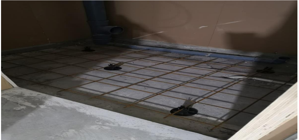
Kuva 10. Väliseinät toimivat topparina Steniuksenkummun työmaalla
