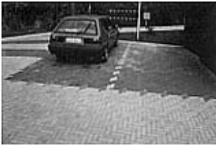
Kuva 12. Pysäköintialueen pinta on tehty betonikivistä.
