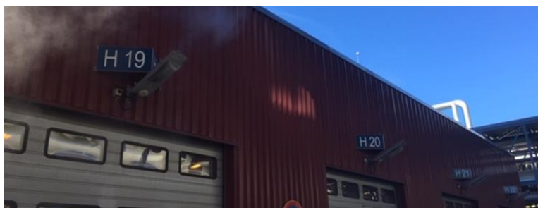
Kuva 15. Pyroflow varaston ovet ja varastojen merkinnot oven yläpuolella
