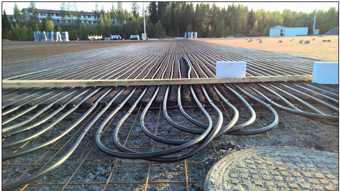
KUVA 10. Lämmönkeruuputkisto asennettuna urattuun asfalttiin Kuopion Lippumäessä.
