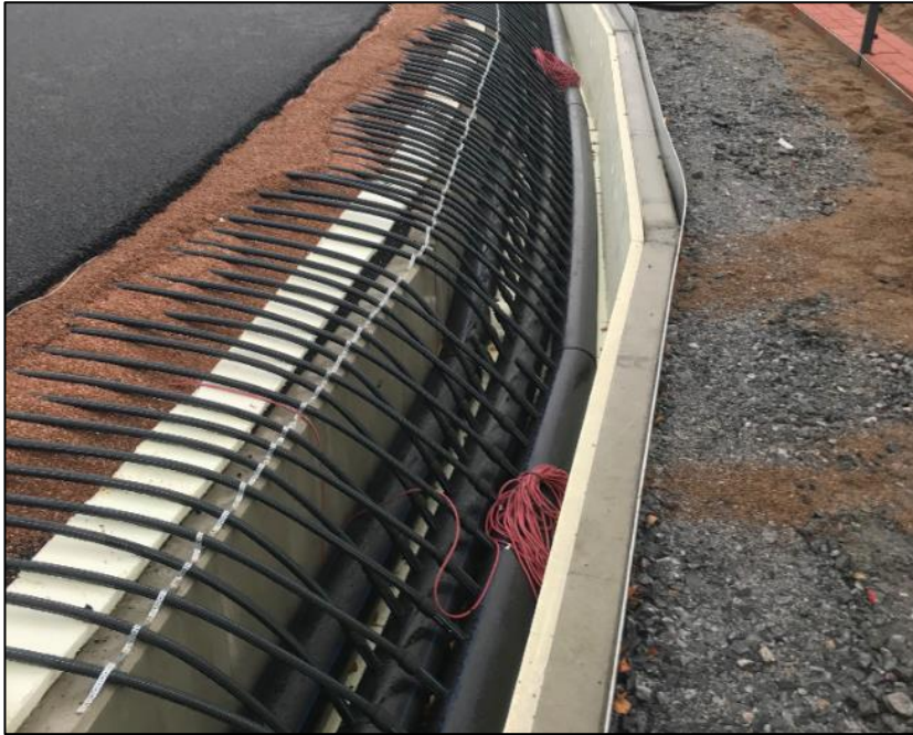
KUVA 14. PE200 jakotukki putkikanaaliin asennettuna
