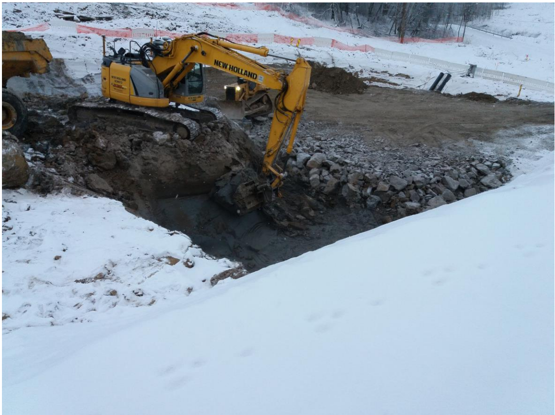
Kuva 8 Massanvaihtokaivannon kaivuu (Raitiotieallianssi, 2018)
