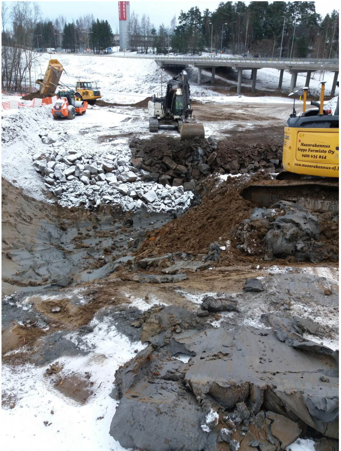
Kuva 11 Kaivannon kaivuu ja täyttö (Raitiotieallianssi, 2018)
