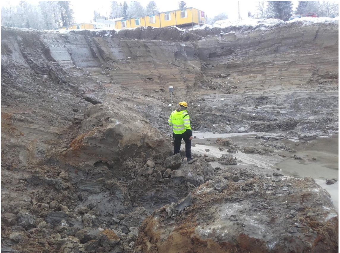
Kuva 9 Kaivannon pohjalla isoja lohkareita (Raitiotieallianssi, 2018)
