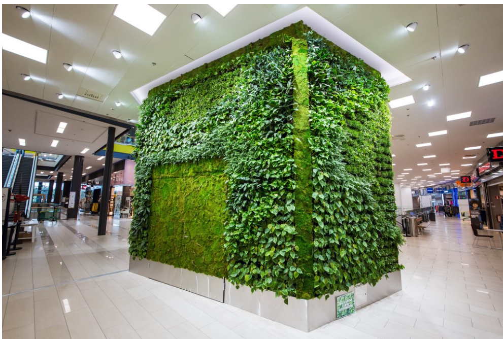
KUVA 14. Kauppakeskuksen talotekniikan maisemointi viherseinillä. (innogreen.fi)
