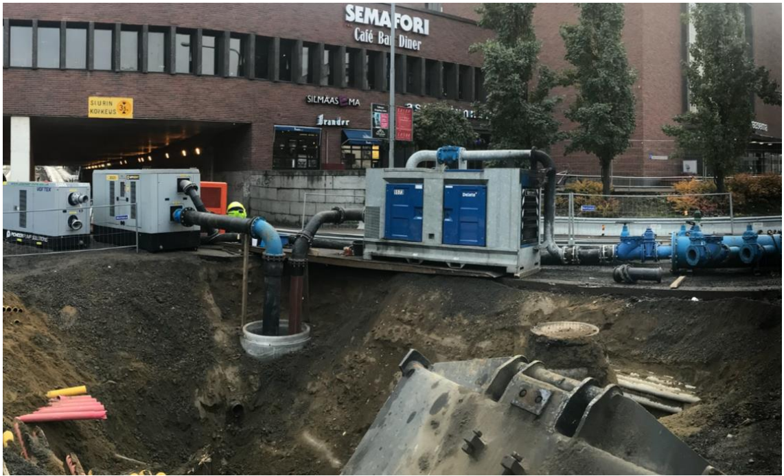
KUVA 5. Ohipumppausjärjestelyt (Kuva: Raitiotieallianssi 2018)
