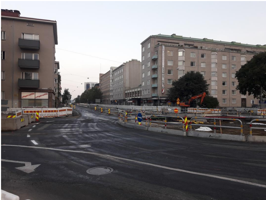
KUVA 36. Työnaikainen kiertoliittymä Sammonaukiolla
