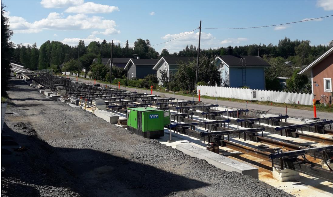
KUVA 38. Kiskot asemoidaan paikoilleen Pandrol-pukkien ja painokivien avulla
