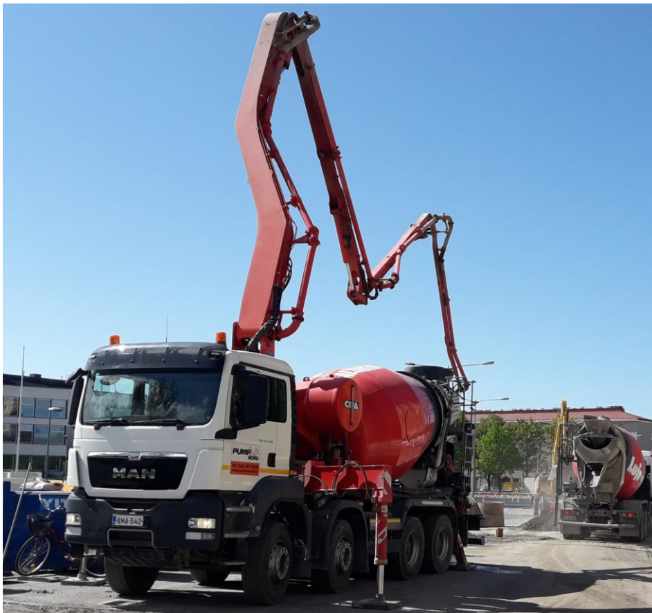
KUVA 37. Betonipumppuautoa käytetään kiintoraidelaattojen valuissa. Ajoneuvon tilantarve tulee huomioida työsuunnittelussa
