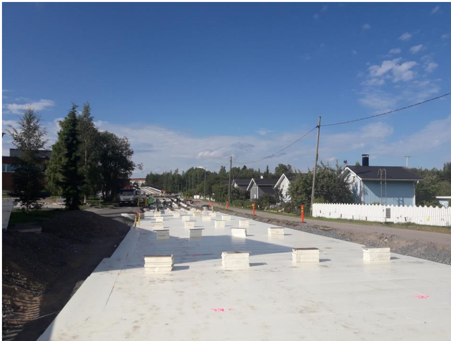
KUVA 9. Radan routaeristys asennettuna
