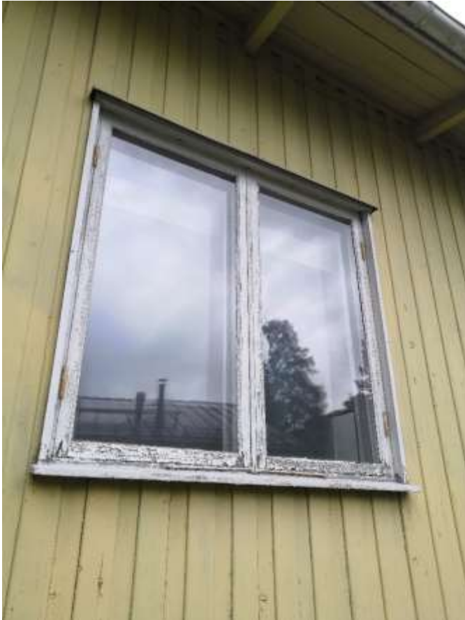
KUVA 5. Alkuperäinen rintamamiestalon ikkuna
