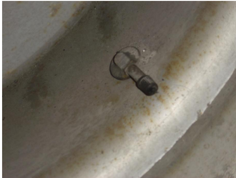
KUVA 27. Hankalasti asennettu venttiili Lähde: Markku Inkinen 2009
