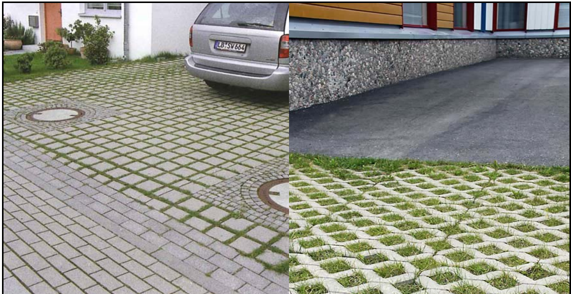
Kuva 10.7 Läpäiseviä päällysteitä (Keskinen 2009, 11)
