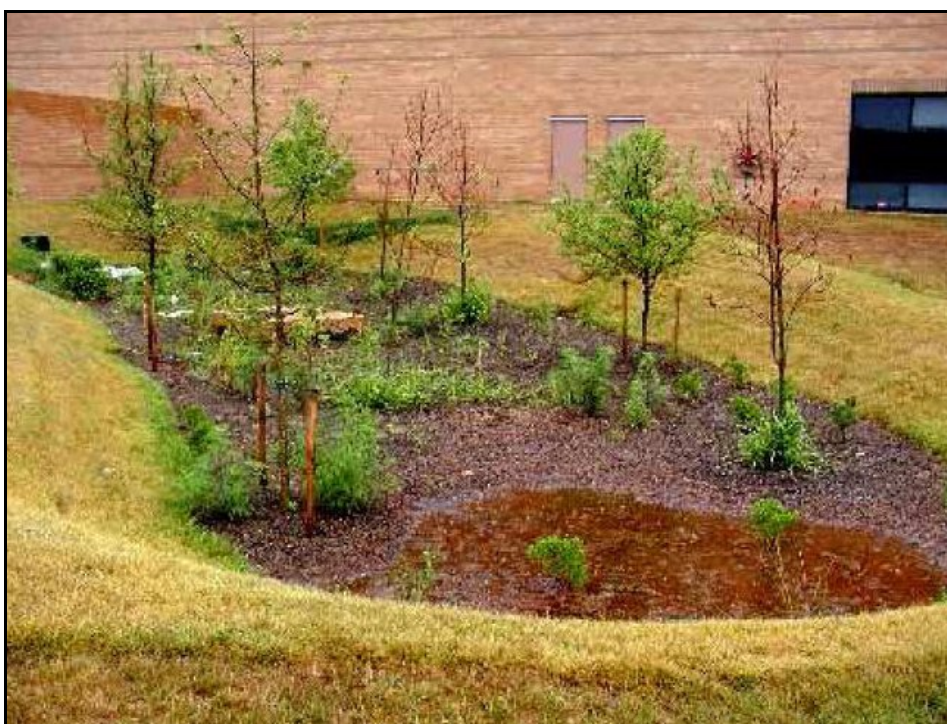
Kuva 10.5 Kasvillisuuden peittämä imeytysallas (Suunnittelukeskus, 17)
