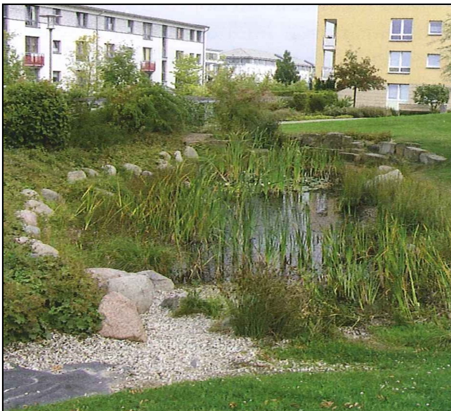
Kuva 10.8 Rakennettu kosteikko (Keskinen 2009, 11)
