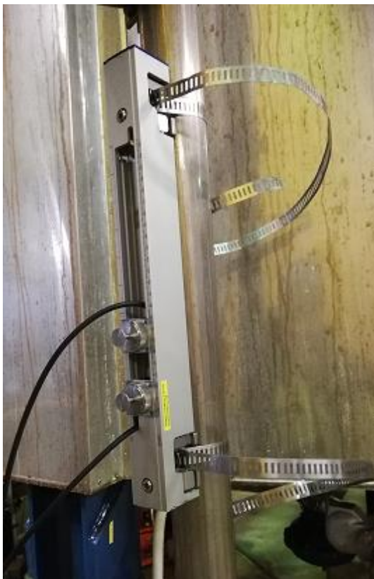
KUVA 6. Krohne Optisonic virtausmittari asennettuna reaktorin lauhdelinjaan.
