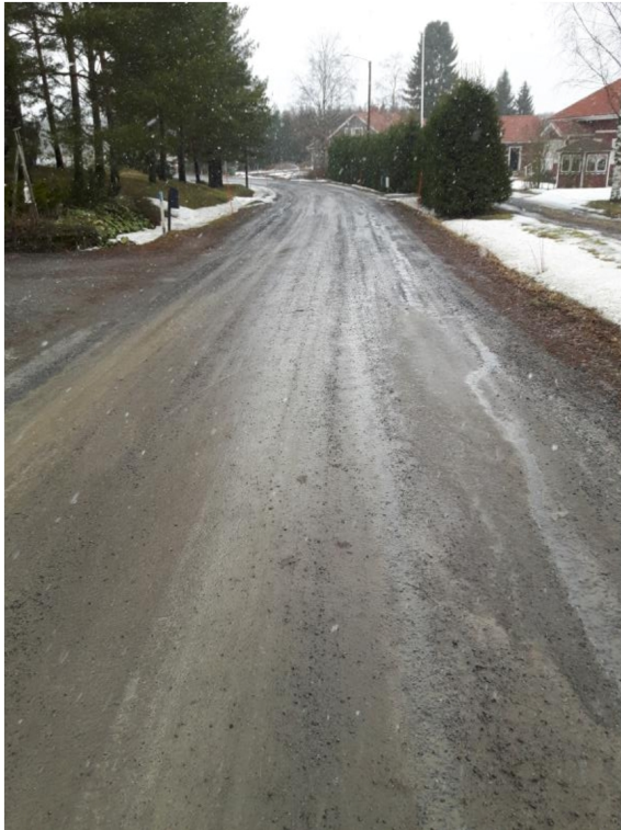
KUVA 9. Paikoitellen, varsinkin paikoissa, missä vesi ei kerry tien pintaan, tien yleisilme ja kunto ovat kohtalaisia. Pienet ojat ovat rakennettu tien molemmin puolin.
