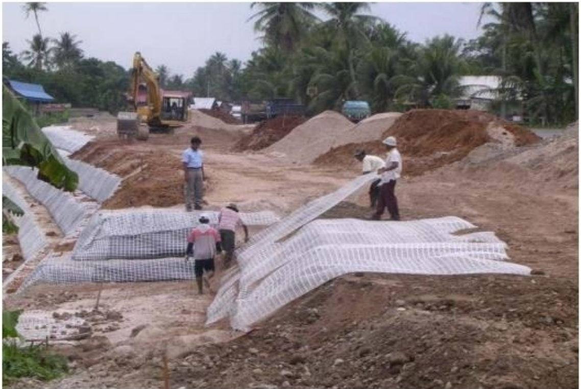
KUVA 25. Pussirakenteen rakentamista geotekstiilillä. (Sara H. 2012, 6.)
