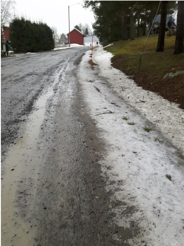
KUVA 4. Tie on painunut ja reunoille on muodostunut reunapalteita, jotka estävät veden kulkeutumisen sivuojiin.
