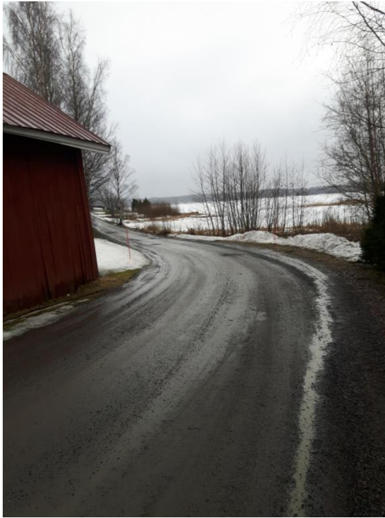
KUVA 8. Tietä on levennetty oikealle. Kapea kohta linja-autoliikenteelle. Sivuojat puuttuvat. Tiellä sijaitsee useita rakennuksia aivan kiinni tielinjassa ja tie on paikoitellen linja-autoille ahdas.
