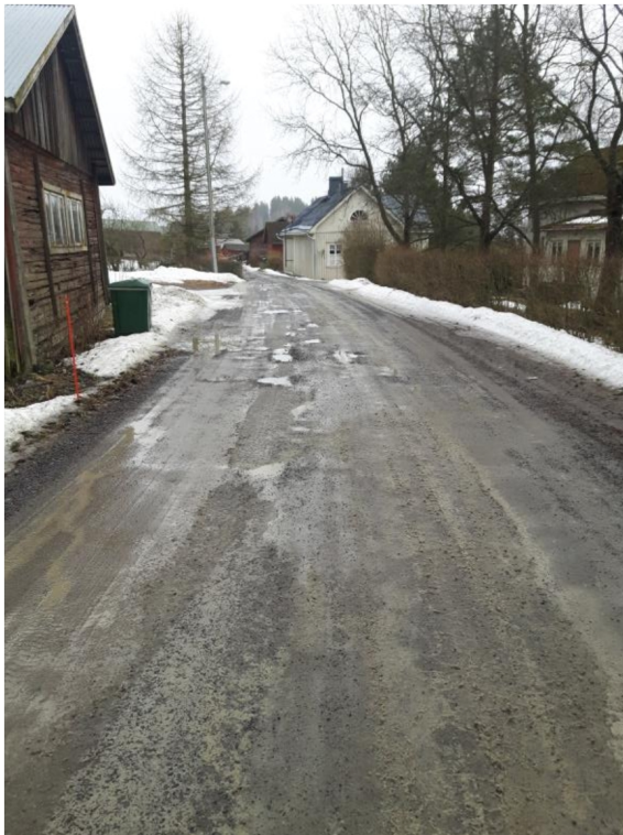
KUVA 1. Sivuojat puuttuvat. Routiminen on aiheuttanut kuoppia ja lammikoitumista.
