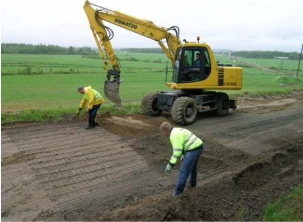
KUVA 19. Teräsverkon asennusta. (Tiehallinto 2009, 59.)
