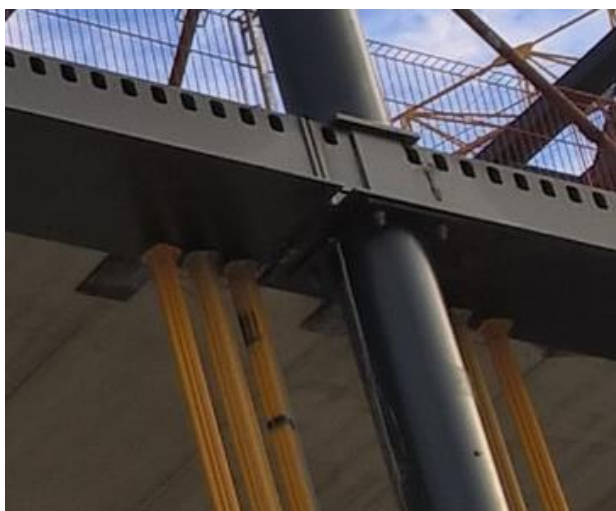
Figur 2. Stämpstöd som stöder upp mellanbjälklagsbalkar. (Ruukki Oy)
