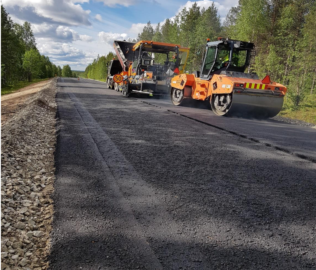
KUVA 21. Kulutuskerroksen asfalttibetonin levitys ja tiivistäminen
