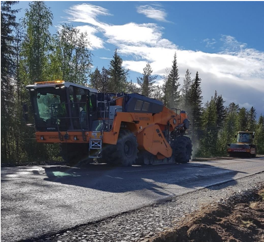
KUVA 8. Vanhan päällysteen esijyrsintä
