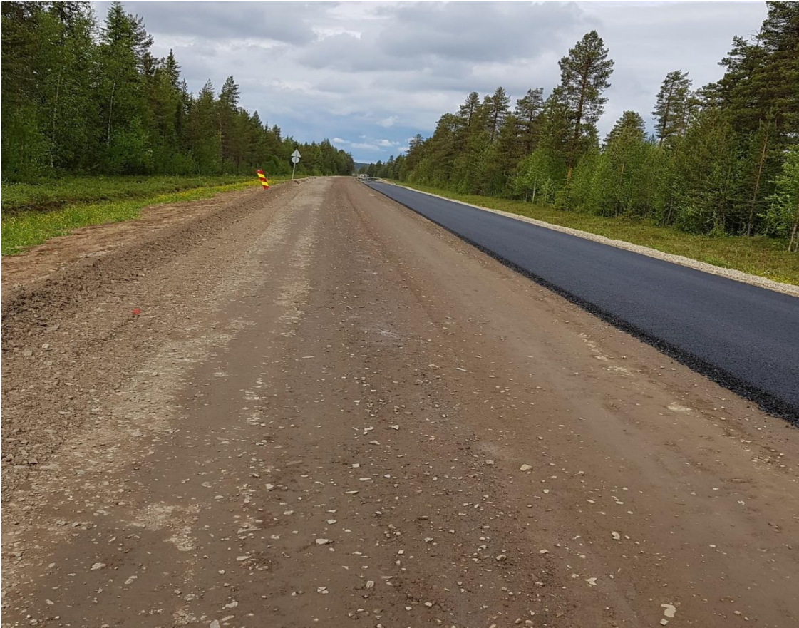
KUVA 20. Kantava asfalttibetonikerros levitettynä sekoitusjyrksitylle tieosuudelle
