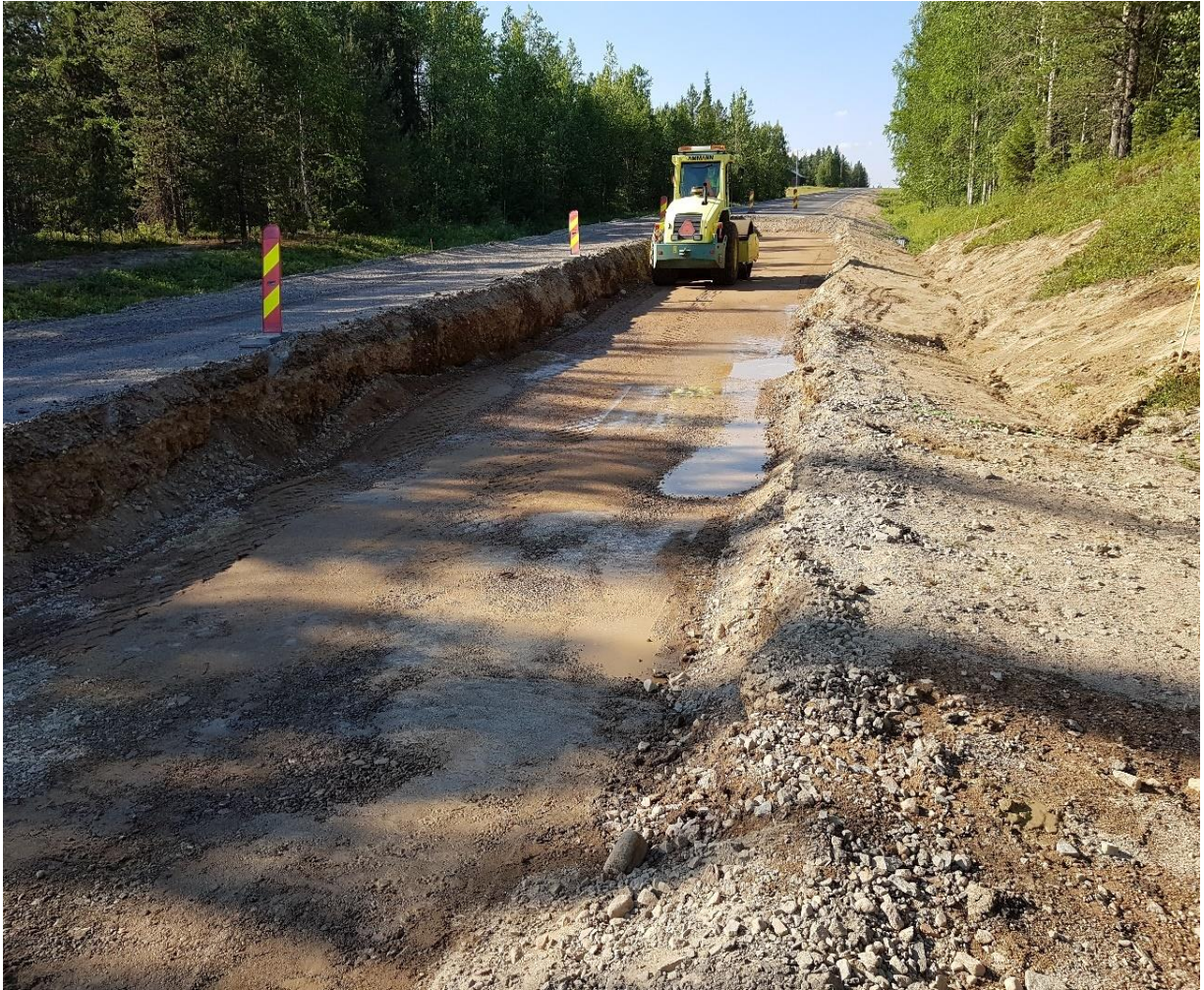
KUVA 17. Jakavan kerroksen tiivistäminen
