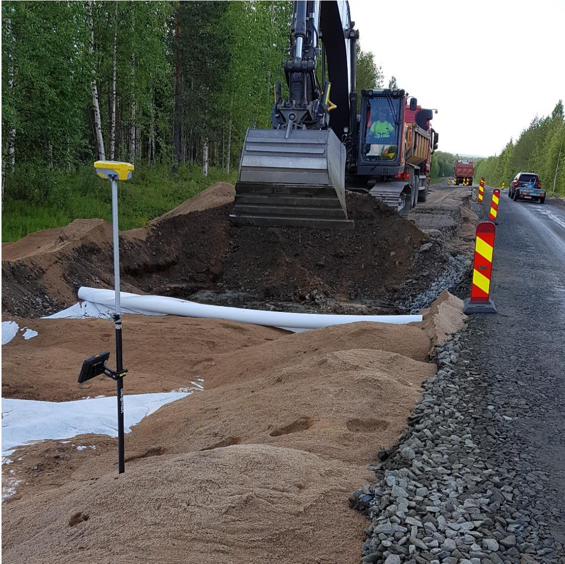
KUVA 16. Hiekan lisäys kaivannon edetessä
