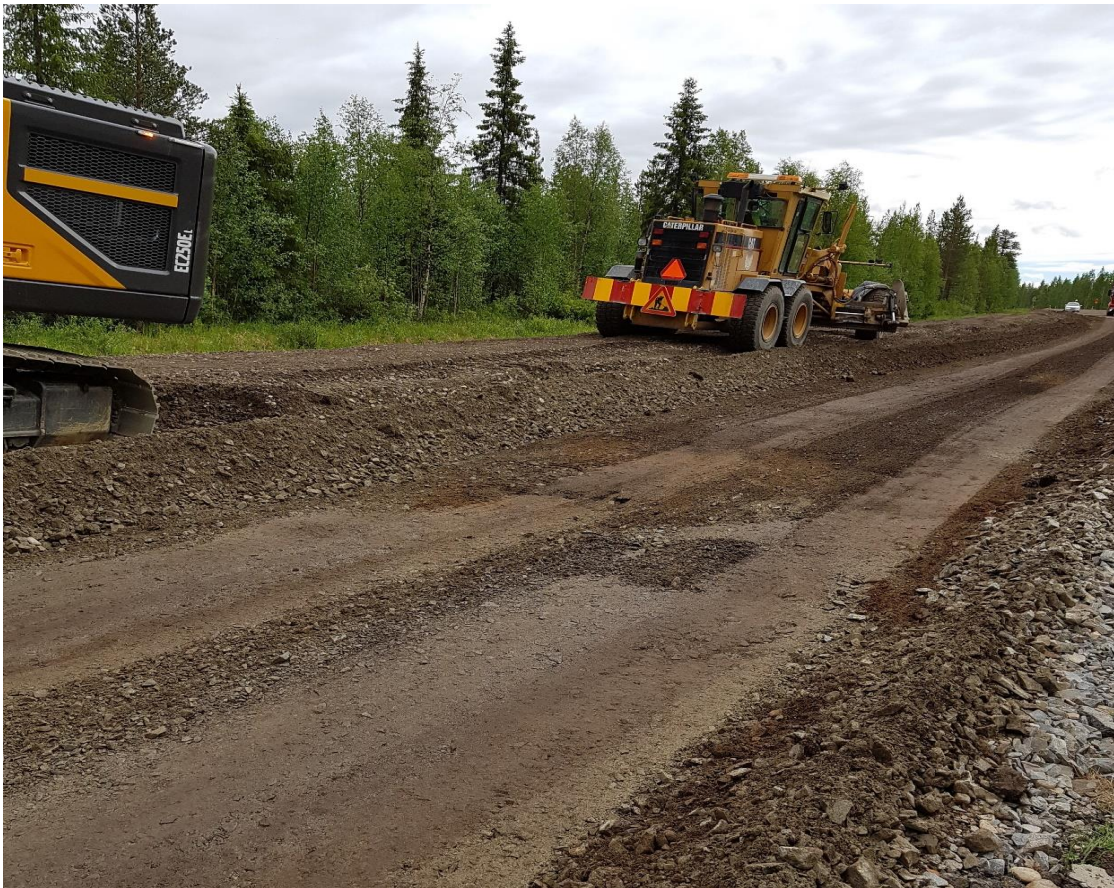
KUVA 13. Tiehöylän käyttö teräverkkojen asennuksessa
