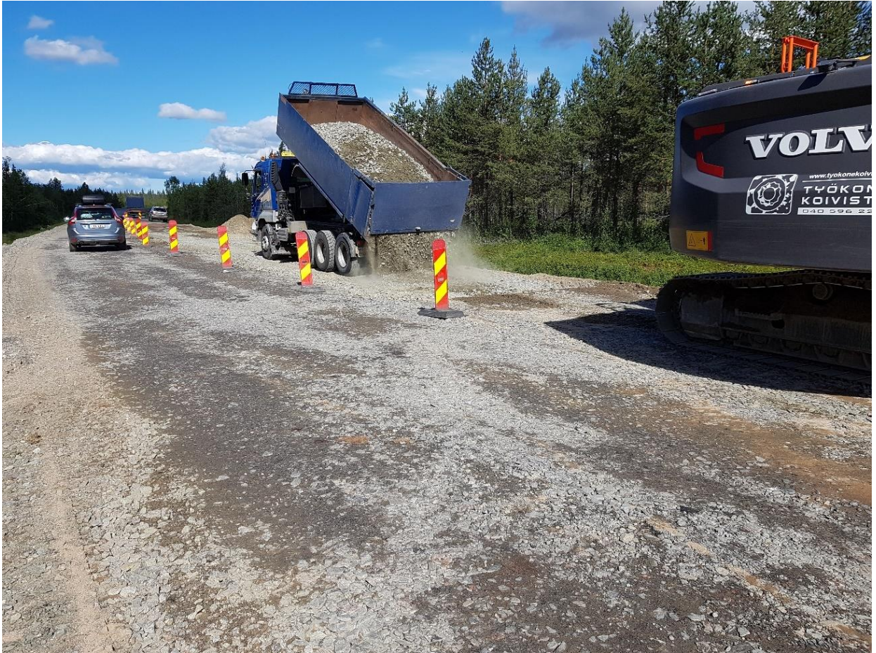
KUVA 18. Kantavan kerroksen (0–56 mm) lisäys
