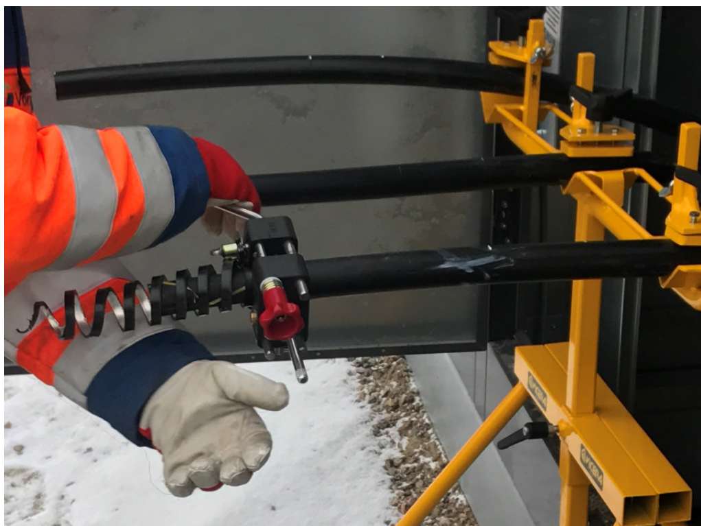
Kuva 38. Kaapelin ulkovaipan ja alumiinilaminaatin kuorinta samanaikaisesti.
