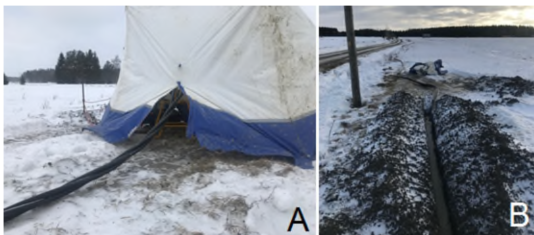
Kuva 35. Kuvassa A suojateltta jatkosasennuksen suojana ja kuvassa B maan pinnalla tehty jatkos.
