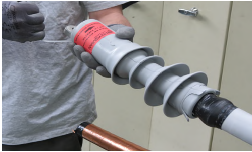
Kuva 5. Prysmian Groupin Coldfit-kylmäkutisteulkopäätteen kutistaminen [17].
