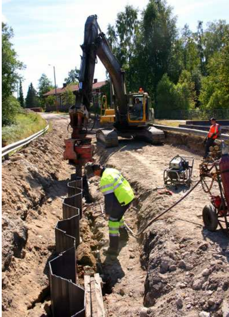
Kuva 3. Ponttiseinä (Koskenjalka 2010)
