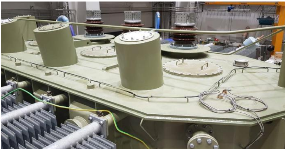
Kuva 26. Muuntajan kansi huollon jälkeen (29.8.2018.)
