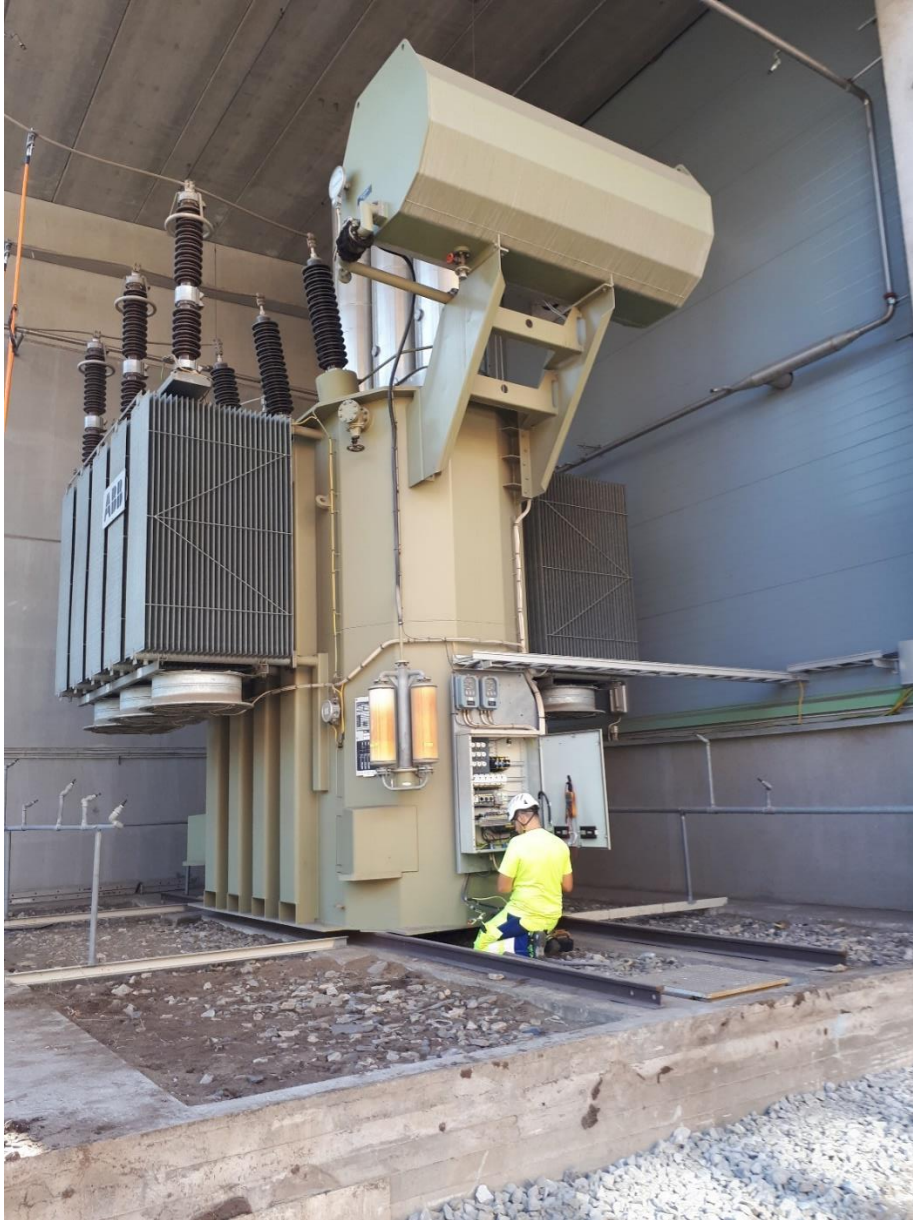
Kuva 9. Muuntajan siirron valmistelua (25.7.2018)
