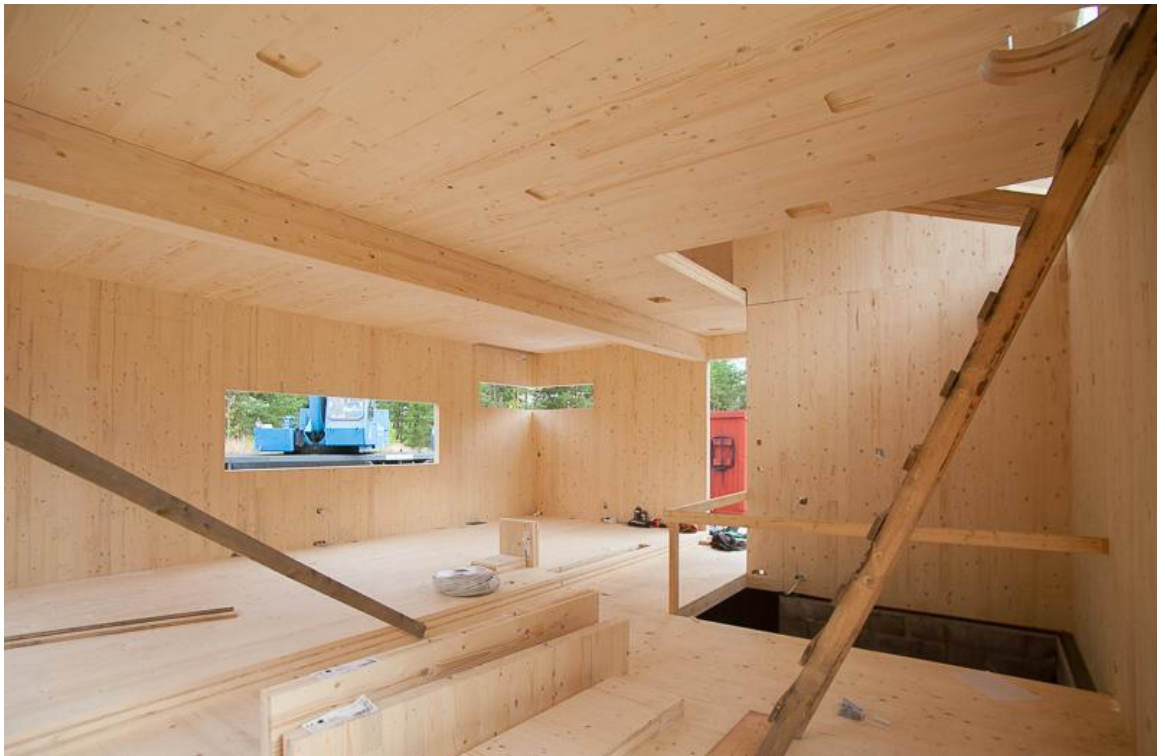
KUVA 9. CLT-levyjien paikalleen asennus (Puuinfo.fi)
