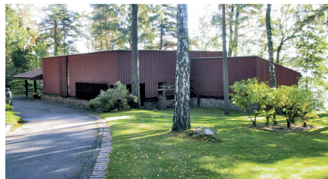
Kuva 11. Suomen Pankin kokousrakennus, valmistunut vuonna 1983, arkkitehtina Pekka Ojonen. 1970-1980 -lukujen täydennysrakentamiselle oli tyypil- listä matala laatikkomaisuus, tumma pystyverhous ja maalle avautuvien jul- kisivujen aukotuksellinen mykkyys.
