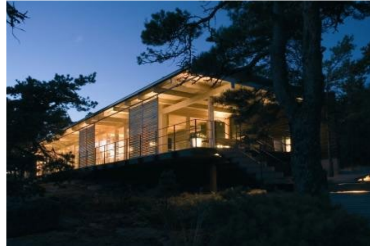
Kuva 31. Huvila Kustavissa. Sigge Architects, 2005.
