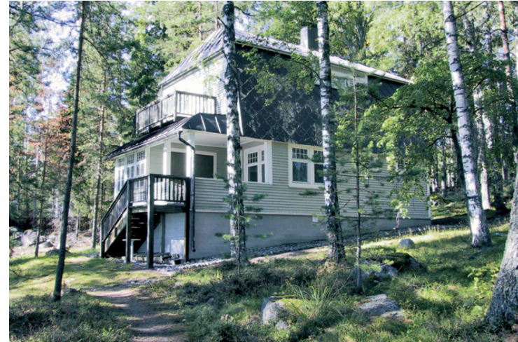
Kuva 16. Rakennuspaikan länsinaapurissa sijaitseva huvila, valmistunut 1910-1914. Huvilan sisätiloja on avarrettu soveltumaan paremmin leiri- ja hartaustointia varten.
