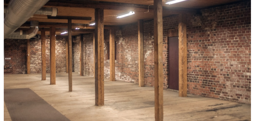
Kuva 41 Sörnäisten Kruununmakasiinin toinen kerros. Pystyhirsipilarit ulottuvat ensimmäisestä kerroksesta kolmannen kerroksen välipohjaan. Kuvassa näkyvät myös pohjoisen julkisivun umpeen laitetut ovi ja ikkunat. Kuvattu 24.9.2018.
