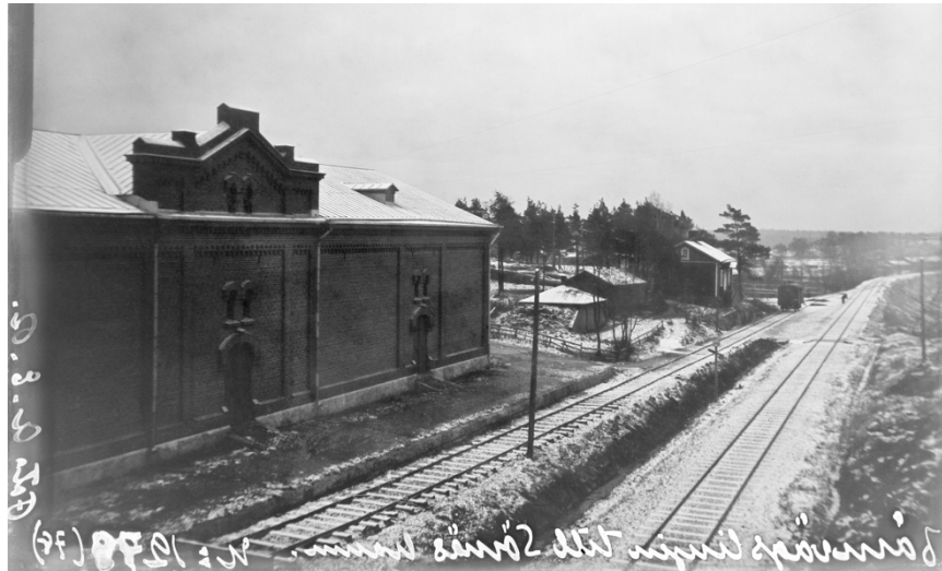
Kuva 26 1900-luvun alussa A.E.Rosenbröjjerin ottama kuva Sörnåsten Kruununmakasiinista. Kuvassa näkyy vuonna 1863 valmistunut Sörnåsten satamarata ja Kruununmakasiinin eteläjulkisivu. Kruununmakasiini on vielä alkuperäisten piirustusten mukainen ilman isoja kattolanternoja. Lähde: Helsingin kaupunginmuseon kuva-arkisto, tunnus N1278.
