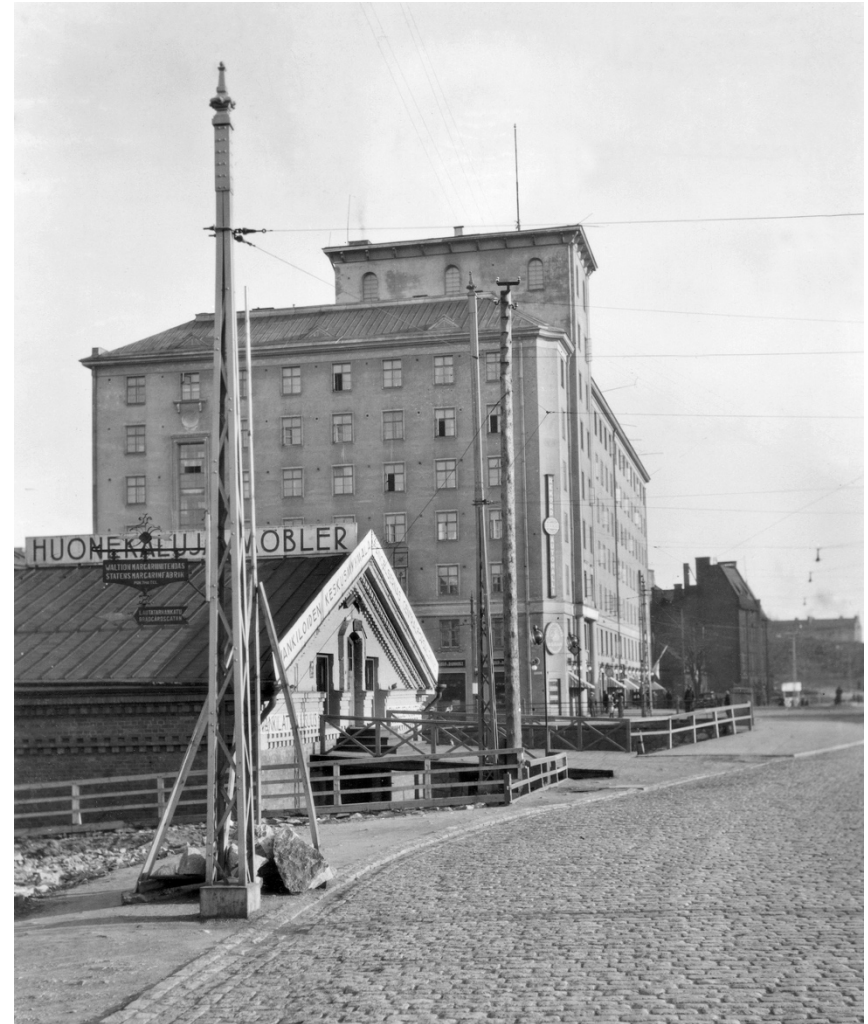
Kuva 27 Sakari Pälsin noin 1930-luvulla ottama kuva. Kruununmakasiinissa näkyy jo vankilan käytön aikana tehtyjä muutoksia, kuten ikkunoiden vaihto sekä isompien kattolaternojen lisääminen (vilaus vasemmassa reunassa). Hämeentien sillan korko on myös kasvanut. Lähde: Helsingin kaupunginmuseon kuva-arkisto, tunnus N3987.
