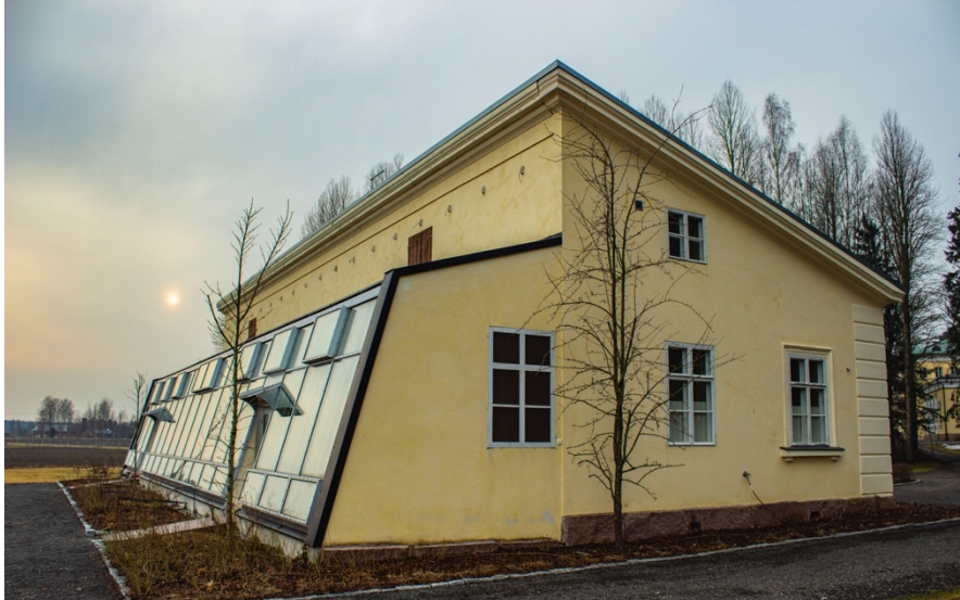
Kuva 54 Vuojoen kartanon orangeria omaa perinteisen orangerian massoittelun; etelässä vinolappeinen lasijulkisivu ja pohjoinen osa suljetumpi ja hieman korkeampi jättäen osien väliin otsakkeen. Kuvattu 4.5.2019.
