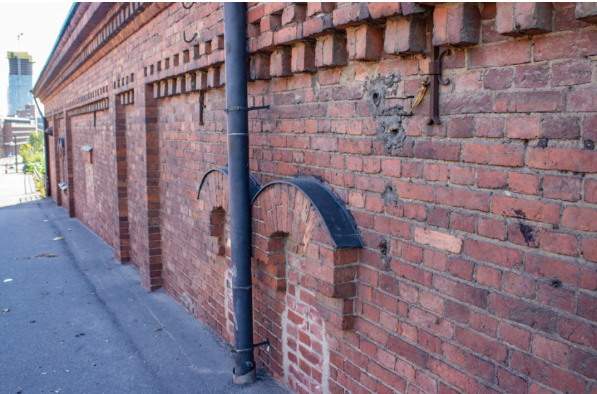
Kuva 37 Sörnäisten Kruununmakasiinin pohjoisjulkisivun ovi- ja ikkuna-aukot on muurattu umpeen ja ne ovat osittain hautautuneet Lautatarhankadun alle. Kuvattu 24.9.2018.
