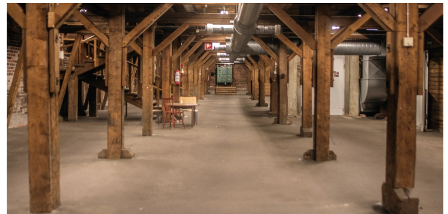
Kuva 40 Sörnäisten Kruununmakasiinin ensimmäinen kerros. Vanhasta laualattiasta ovat muistuttamassa hirsipilareiden juurella olevat hirsiarinoiden pätkät. Näiden pilareiden varaan myös viljasii- lot oli rakennettu. Lattia on pinnoitettu asfaltilla. Kuva otettu 24.9.2018.
