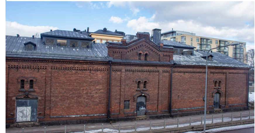
Kuva 36 Sörnäisten Kruununmakasiinin eteläjulkisivu Junatien varrella. Eteläjulkisivun keskimmäistä sisäänkäyntiä korostavat tuplapilasterointi sekä päätykolmio. Kuva otettu 10.3.2019.
