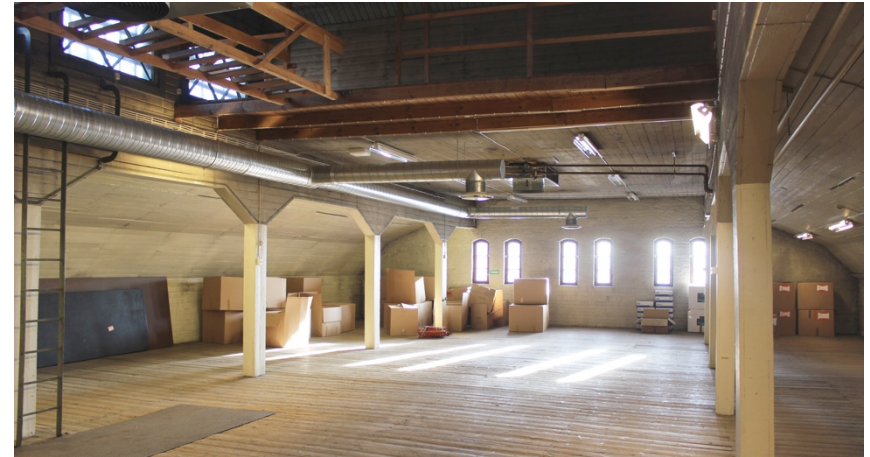
Kuva 45 Kolmannen kerroksen ikkunat ja vankilan käytön aikana lisätyt hirsipilarit. Yläkulmassa näkyy myös kattolanternan ikkunoita. Kuvattu 24.9.2018.
