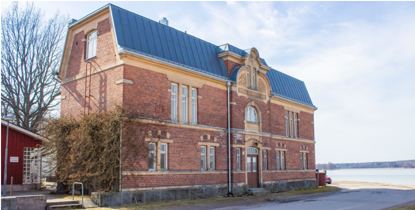
Kuva 22 Vuonna 1903 valmistunut kylpylärakennus Ekenäs Badinrättning kuvattuna Raaseporissa 5.4.2019. Suunnitellut Hjalmar Åberg.
