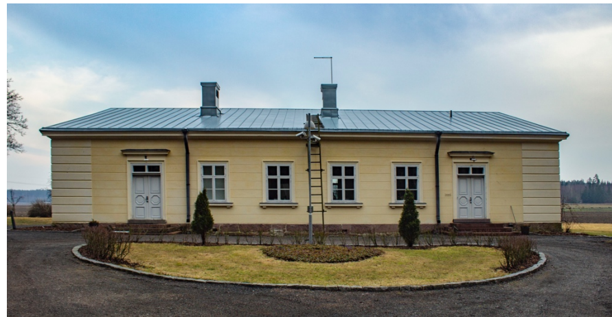
Kuva 53 Vuojoen orangerian pohjoisjulkisivu. Orangeriassa on selkeästi näkyvissä C.L. Engelin kädenjälki. Kuvattu 5.4.2019.
