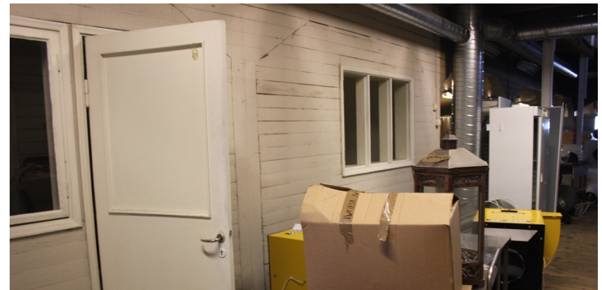
Kuva 46 Vankilan käytön aikana kolmanteen kerrokseen rakennettuja huoneita. Tällä hetkellä kolmannessa kerroksessa säilytetään sekalaista kaupungin tavaraa. Kuvattu 24.9.2018.
