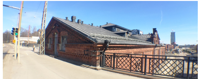
Kuva 30 Sörnäisten Kruununmakasiinin länsi- ja eteläjulkisivut kuvattuna Hämeentien sillalta 18.4.2019.
