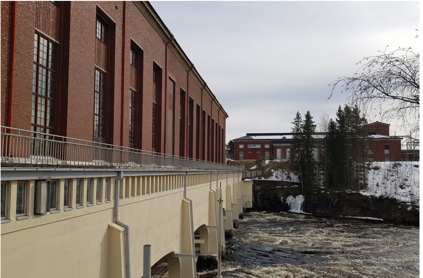
Kuva 11. Imatran vesivoimalaitos on perusparannustyön valmistuttua vuonna 2015 Suomen suurin vesivoimalaitos teholtaan sekä tuotannoltaan.
