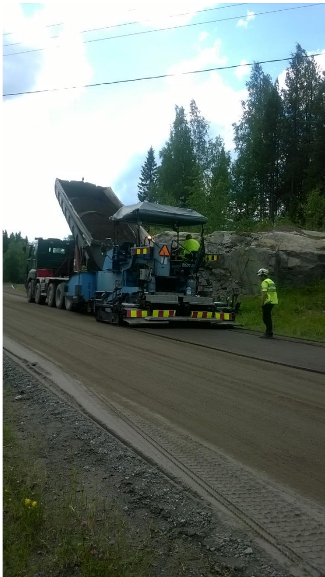
KUVA 3. Masuunihiekan levitys käynnissä (Korpela, Digikuva, 2017)
