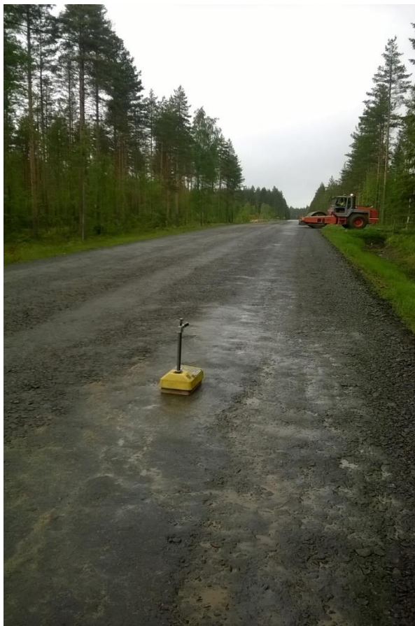
KUVA 7. Tiiviiden ja kosteuden mittaus käynnissä Troxler 3440 -laitteella (Korpela, Digikuva, 2017)
