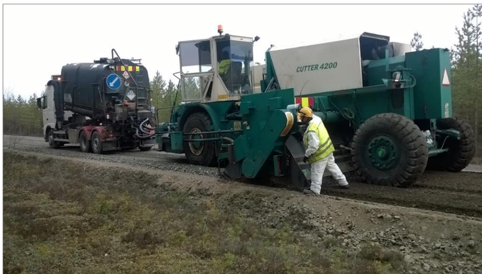
KUVA 2. Vaahtobitumistabiloinnin STJYR -vaihe käynnissä (Korpela, Digikuva, 2017)
