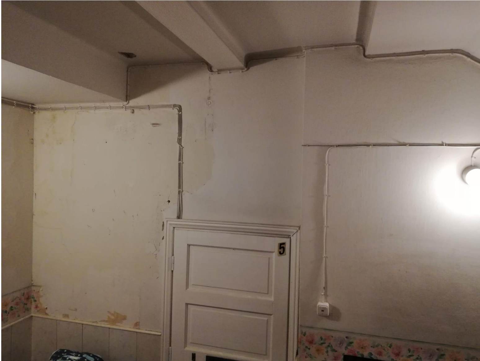
Kuva 8. Ensimmäisen kerroksen lähtötilanne.
