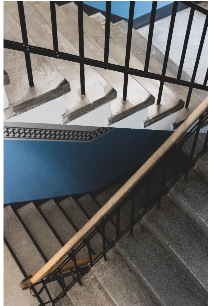
Kuva 1. Jukolankulman uusi porrashuone.
