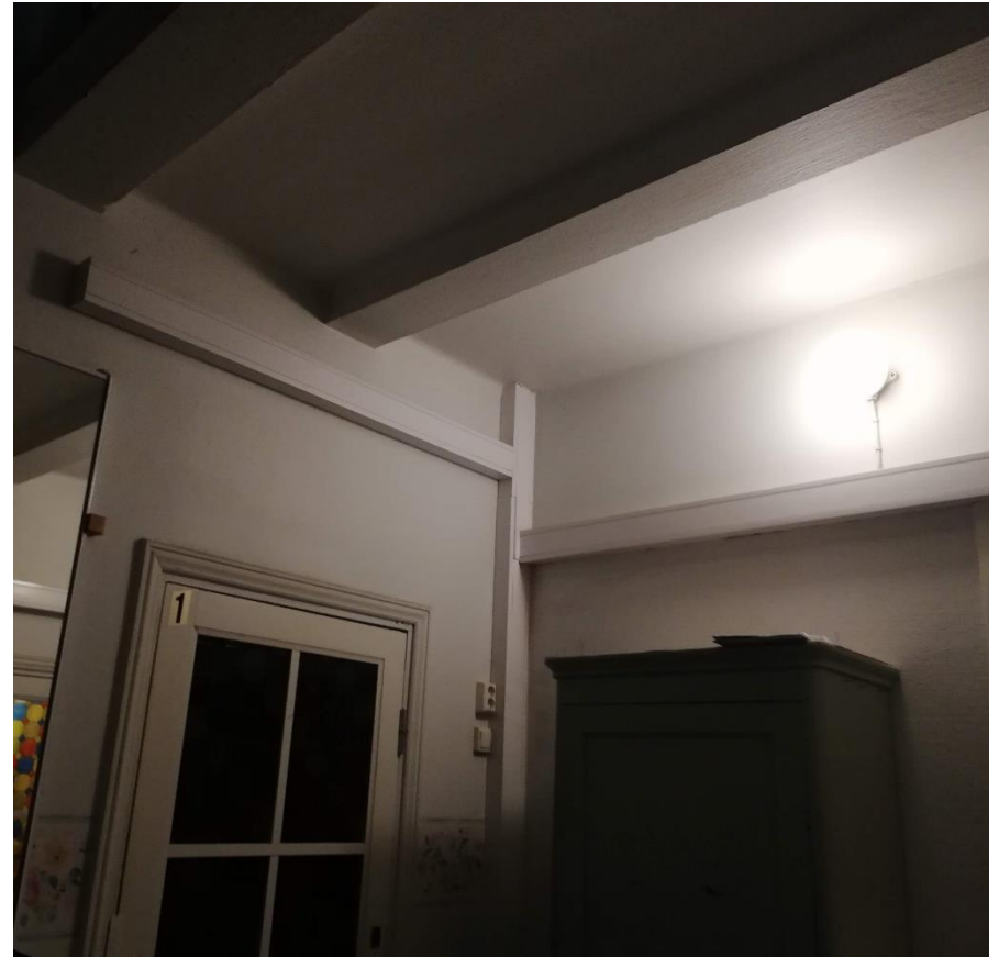
Kuva 16. Toisen kerroksen koteloinnit ennen kunnostustöitä.
