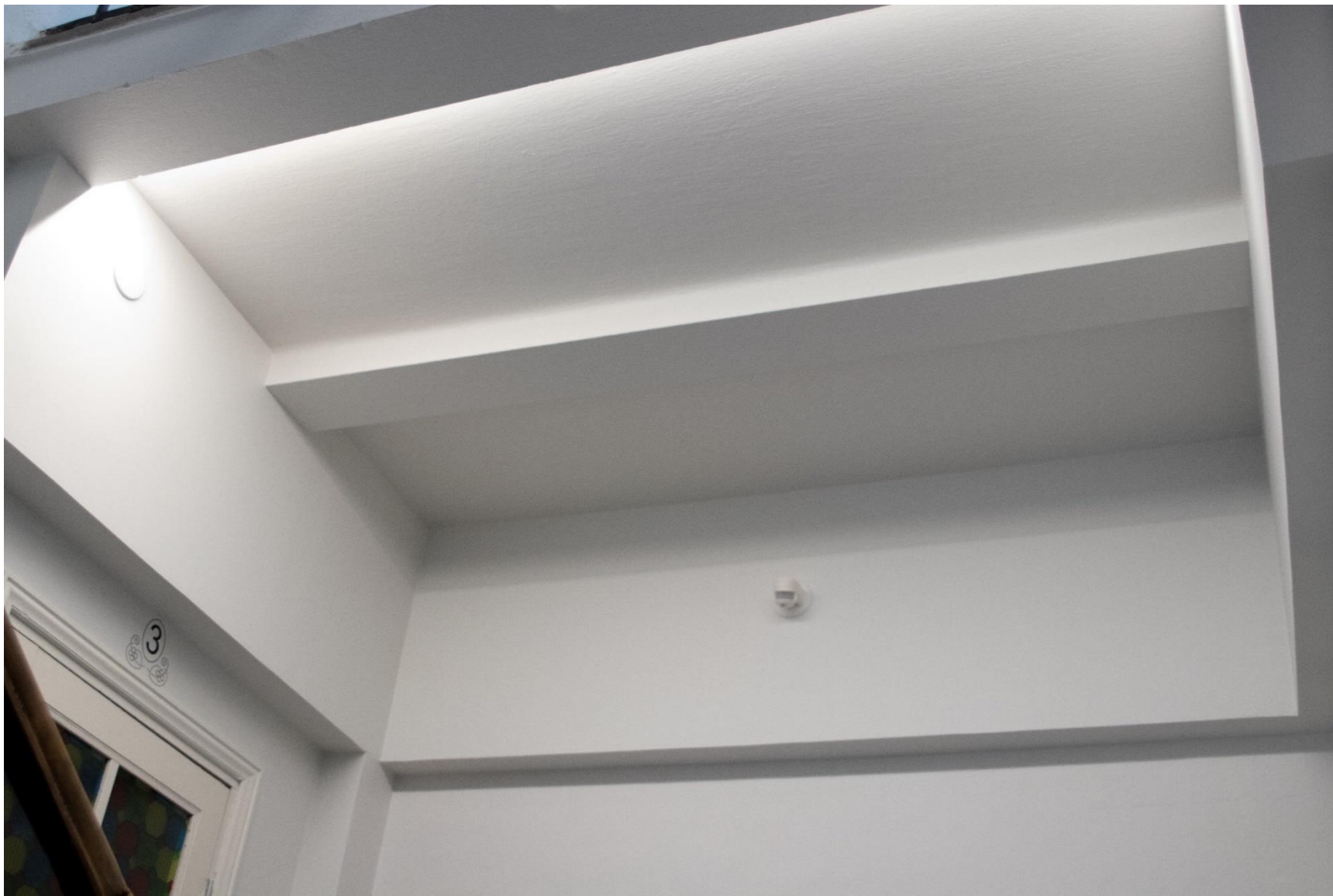
Kuva 27. Toisen kerroksen sähkökoteloinnit.
