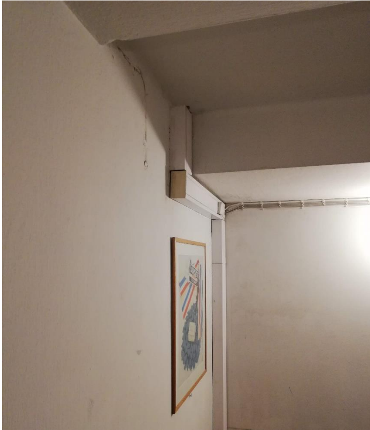
Kuva 15. Ensimmäisen kerroksen koteloinnit ennen kunnostustöitä.
