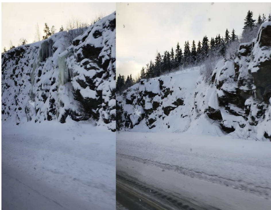
Kuva 20. Toijalan kallioleikkaukset ikkunasta nähtynä, helmikuu 2019.
