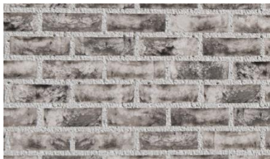
KUVA 9. Isot julkisivupinnat on tehty puolen ki- ven juoksulimityksellä (Mehtola 2019)
