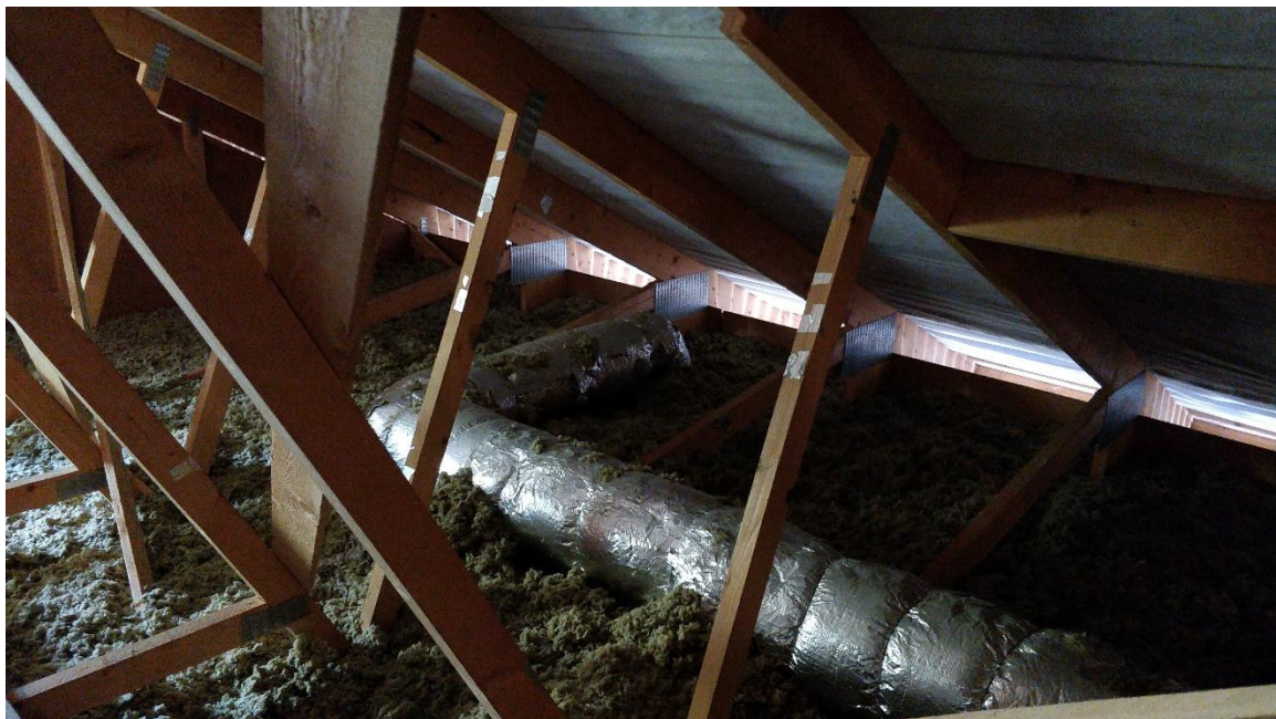
Kuva 9. Hankalasti saavutettavista kohteista kuten ullakko on syytä ottaa valokuvia kuntoarvioraporttia varten (Nissinen 2019-05-05)
