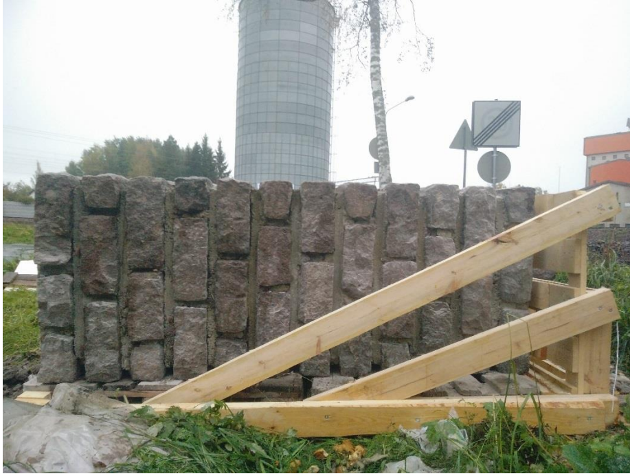
Kuva 11. Pylväänkappale valmiina käännettäväksi pystyasentoon (Heikkinen 2018)
