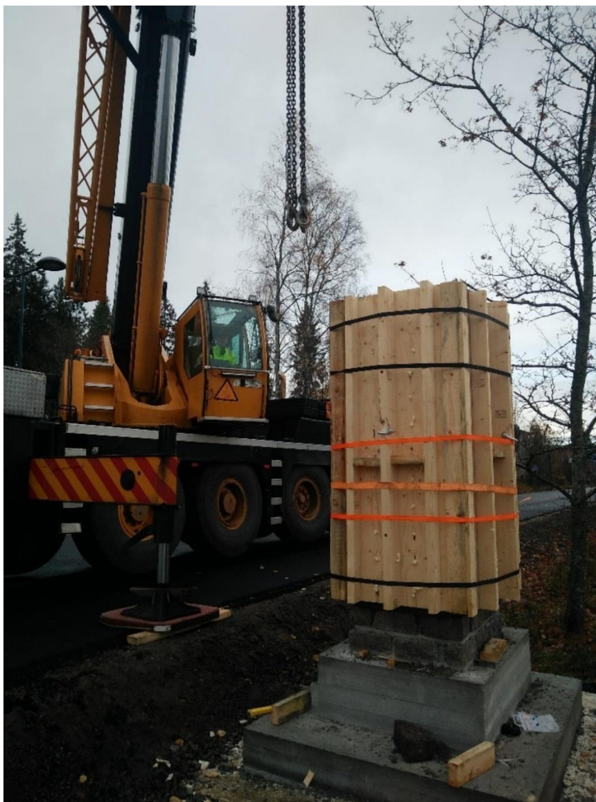
Kuva 13. Liebherr-nosturiauto on suorittanut tehtävänsä (Heikkinen 2018)
