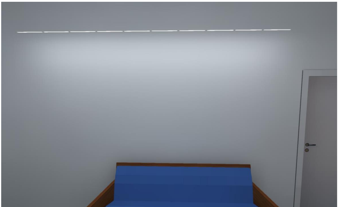
Kuva 10. LED-nauha noin 40 senttimetriä irti seinästä.
