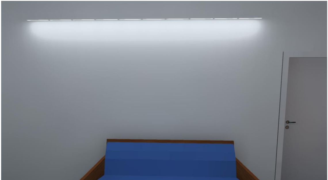
Kuva 9. LED-nauha liian lähellä seinää
