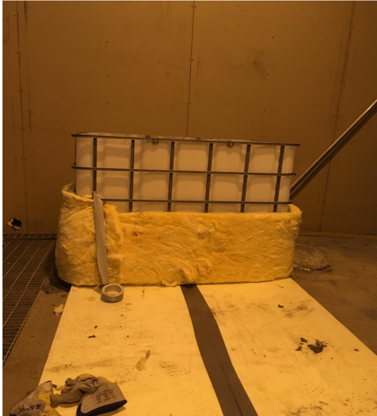
Lämpörasitusaltaan eristäminen villalla
