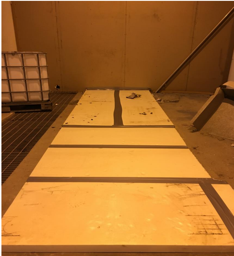
Lämpörasitusaltaiden pohjan eristys
