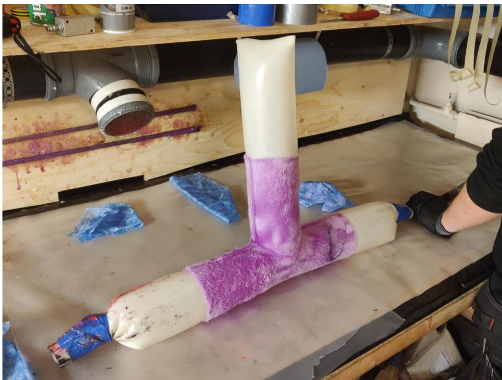
Kuva 9. Kyllästetty haarapala asennettuna erikoistyökalun päälle.
