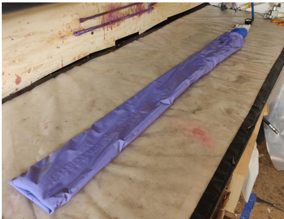
Kuva 5. Sisäpussista valmistettu asennustyökalu.
