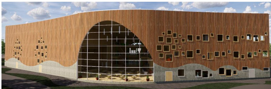
KUVA 38. Julkisivuaukotus rakennuksen pohjoisseinällä (Kiesiläinen 2019-05-16)
