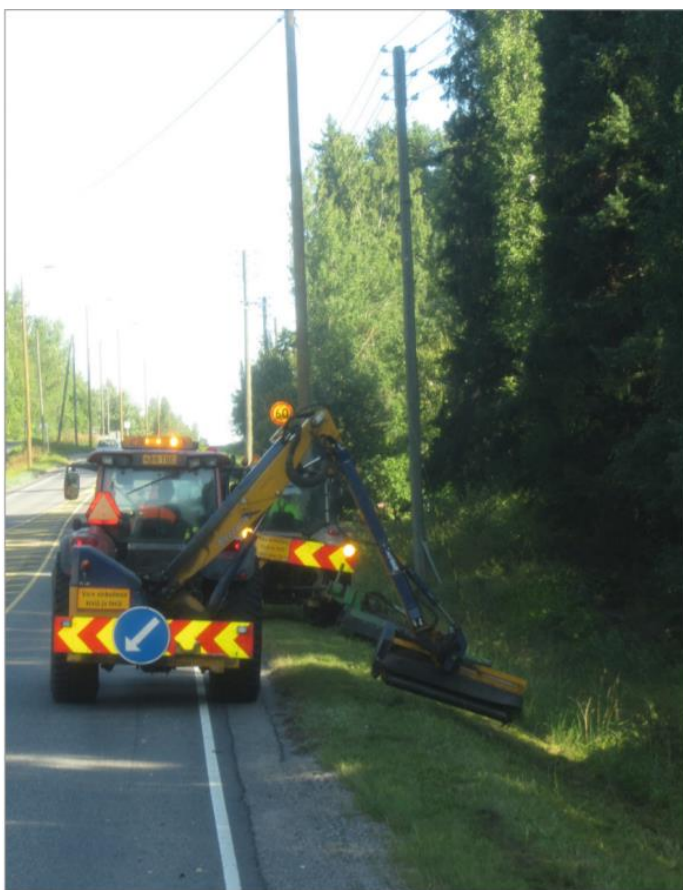
Kuva 11. Peruskone, jossa kiinni puomisto kelamurskaimella (Liikennevirasto 2014, 102)
