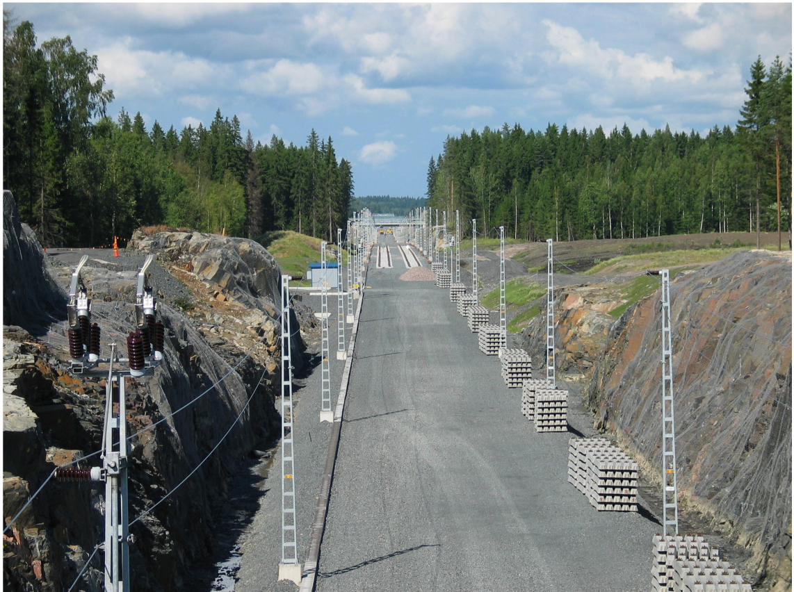
Kuva 5. Pohjasepelikerroksen tasattua pintaa ja betonipöllinippuja Kerava–Lahti oikoratatyömaalla (7).
