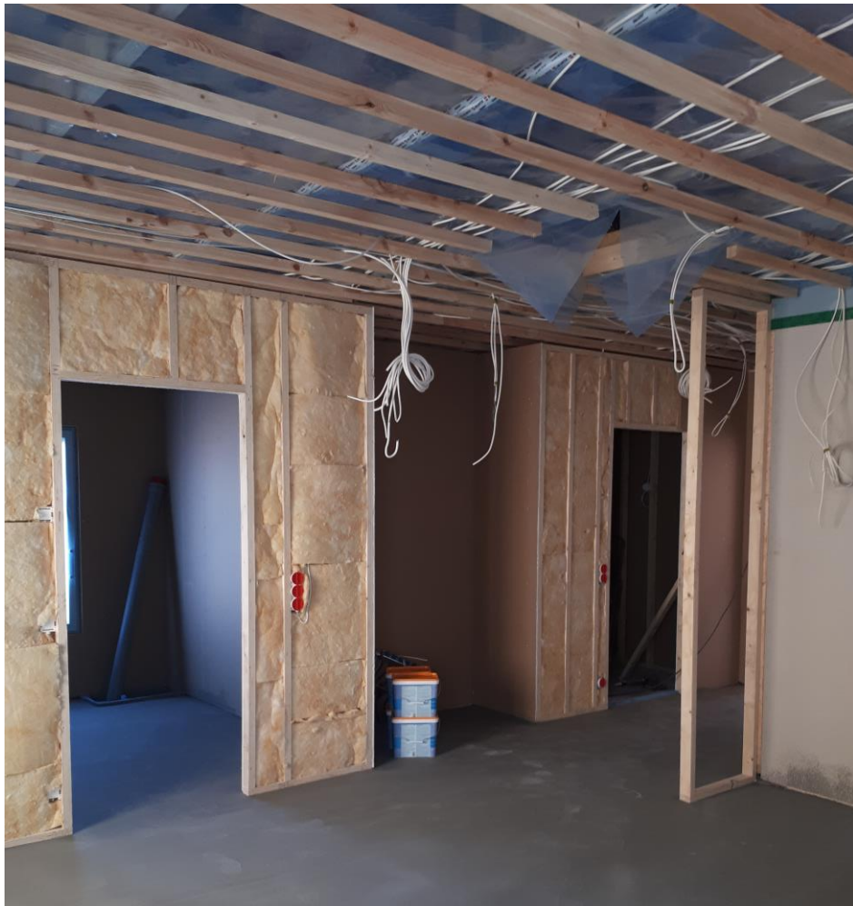
Kuva 17 Väliseinien ja yläpohjan valmistusvaihe.
