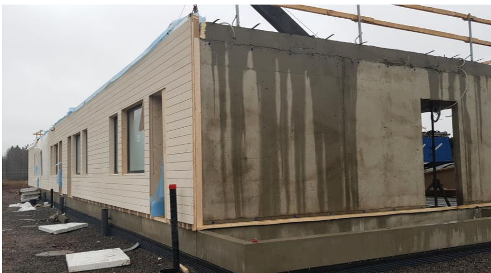
Kuva 5 Julkisivun kulma etelään.
