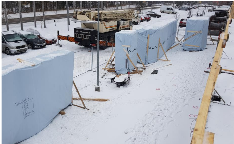
Kuva 15 Autonosturilla nostetut elementtiniput työmaan varastointi paikalla.
