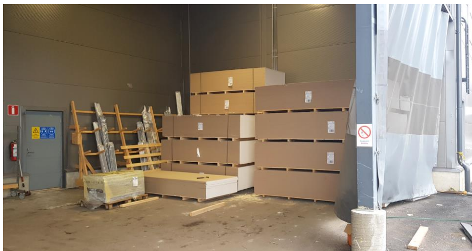
Kuva 9 Kipsilevyt kosteudelta suojassa.
