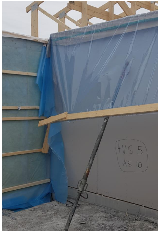
Kuva 16 Huoneistonvälisen elementin suojaus.
