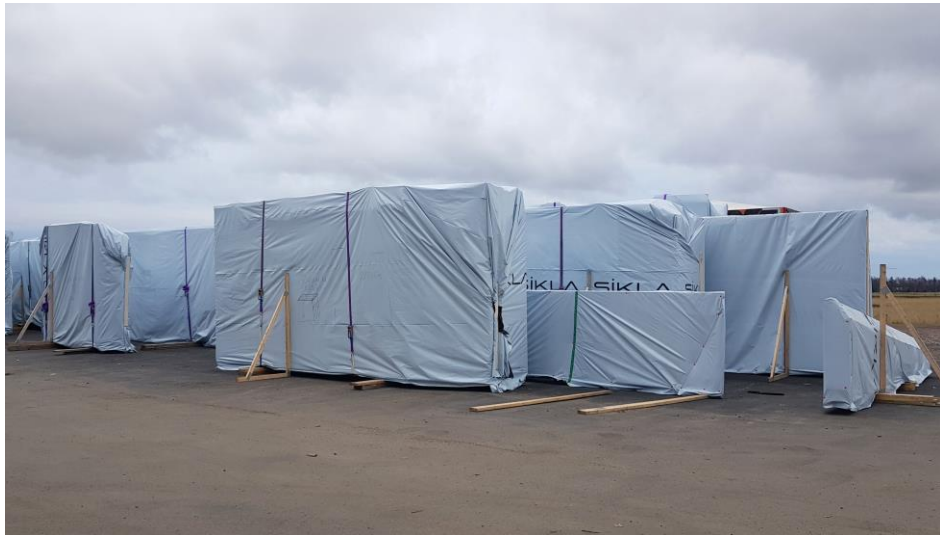
Kuva 12 Elementtiniput odottamassa kuljetusta.
