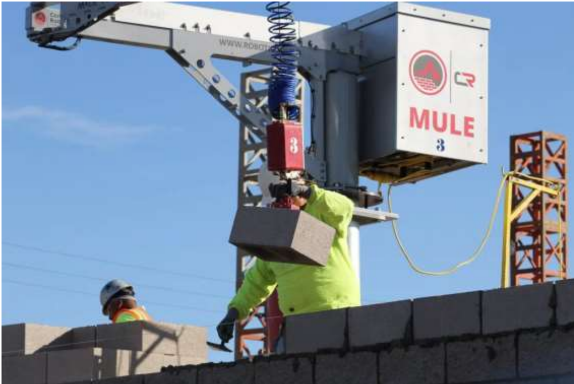
KUVA 13. MULE käytössä työmaalla (32)
