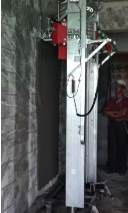
KUVA 19. Laastin kiinnitys seinään (38)
