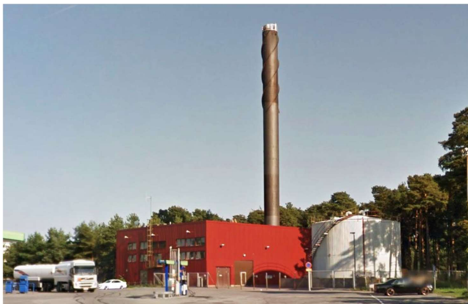
Kuva 7. Tiilimäen lämpökeskus. (Nyqvist 2016)
