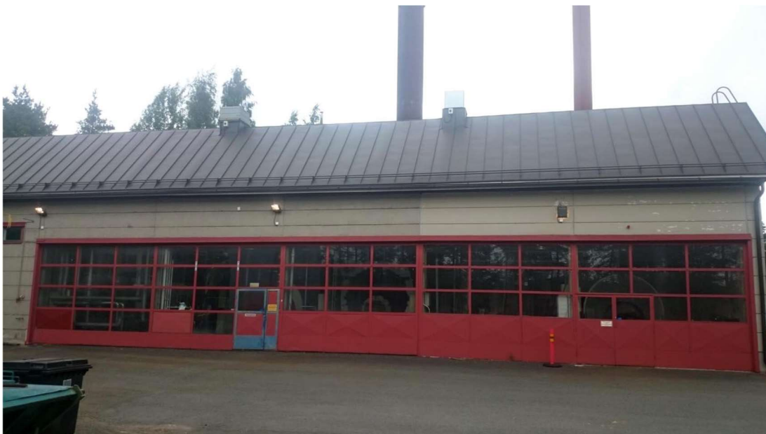
Kuva 3. Harjavallan teollisuuskadun lämpökeskus. (Pärssinen 2016)
