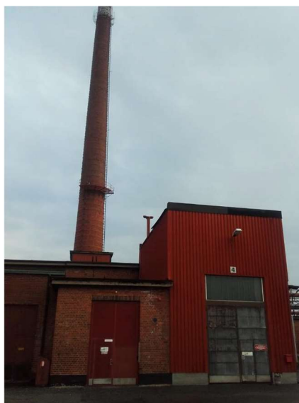
Kuva 5. Metallinkylän lämpökeskus. (Nyqvist 2016)
