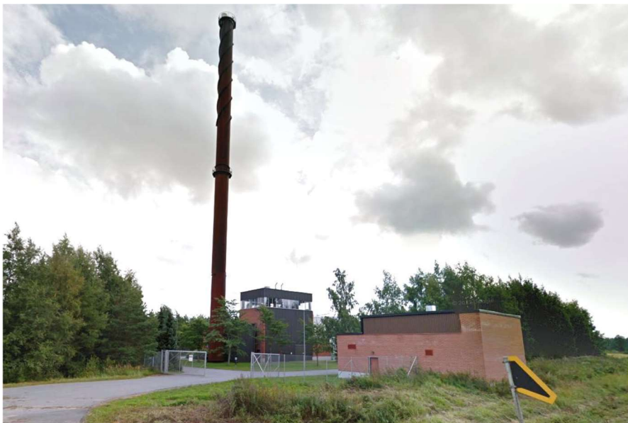
Kuva 8. Ulasoorin lämpökeskus. (Nyqvist 2016)
