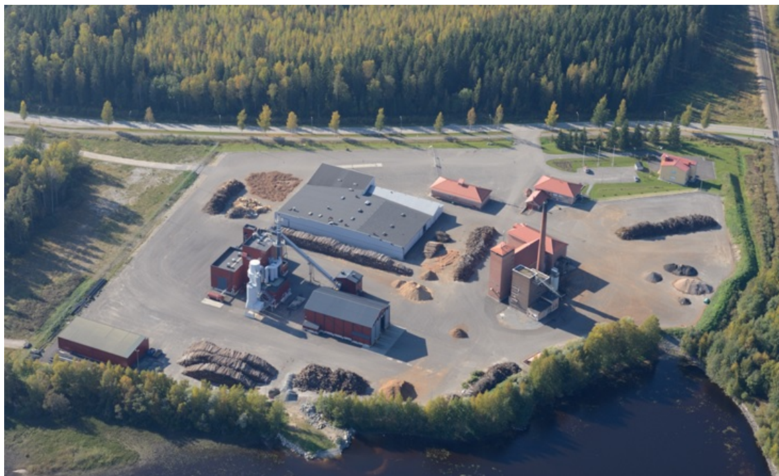
KUVA 2. Varissaaren voimalaitosalue. (Keuruun Lämpövoima Oy 2015)
