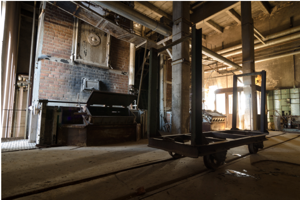
KUVA 27. Polttoaineensyöttötaso ja vanha halkovaunu (Pollari 2015).
