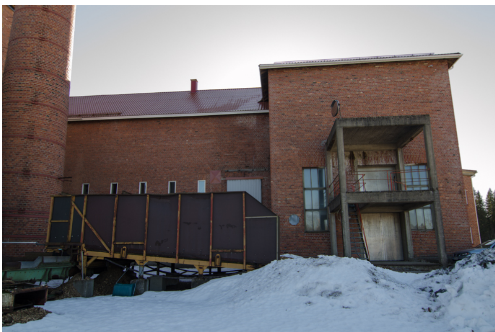
KUVA 24. Rakennuksen pohjoispuoli (Pollari 2015).
