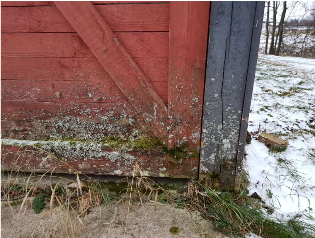
Kuva 1. Ulkoseinien vierellä kasvillisuutta. Ulkoseinän puu rakenteet lähellä maanpintaa, mikä mahdollistaa kosteusvauriot puuosissa.
