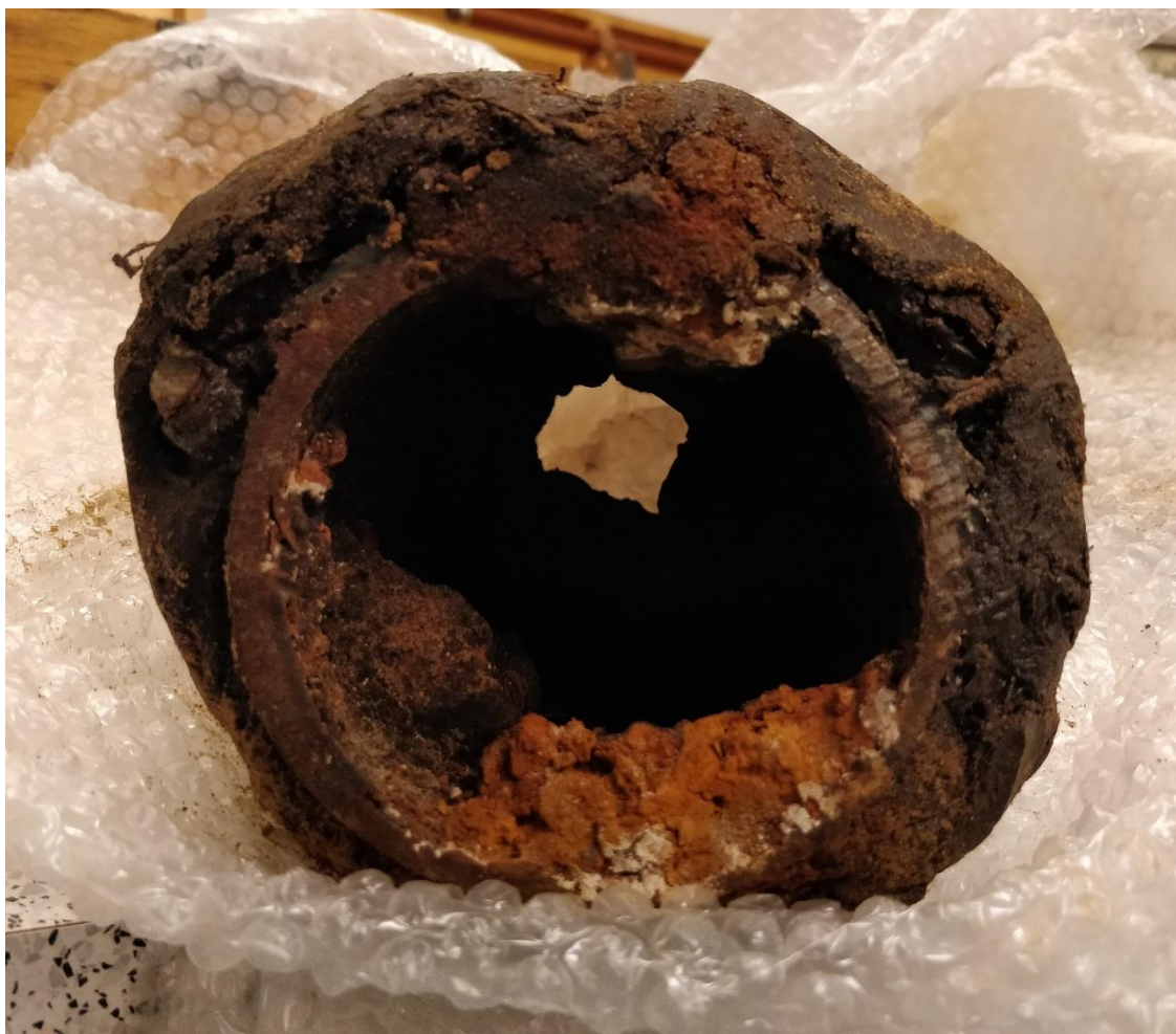
Kuva 3. Korroosion vaikutuksia teräsputkessa (Piirainen 2019-05-10).
