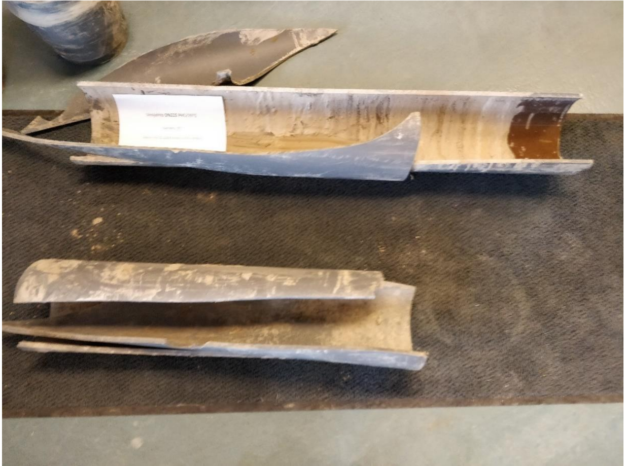
Kuva 5. 225 mm PVC-putki haljennut pituussuuntaisesti. Putken käyttöikä oli n. 48 vuotta, 1971-2019. Putkikirkon aikana vuotomäärä arviolta 4000 m 3 noin 3-4 tunnin aikana. (Piirainen 2019-05-10.)
