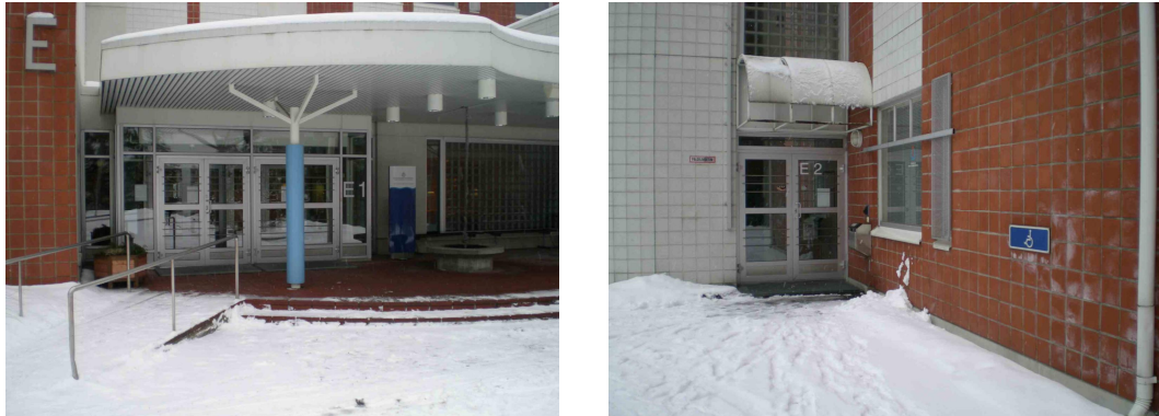
Kuva 5. E-rakennuksen pääsisäänkäynti ja vaihtoehtoinen sisäänkäynti
