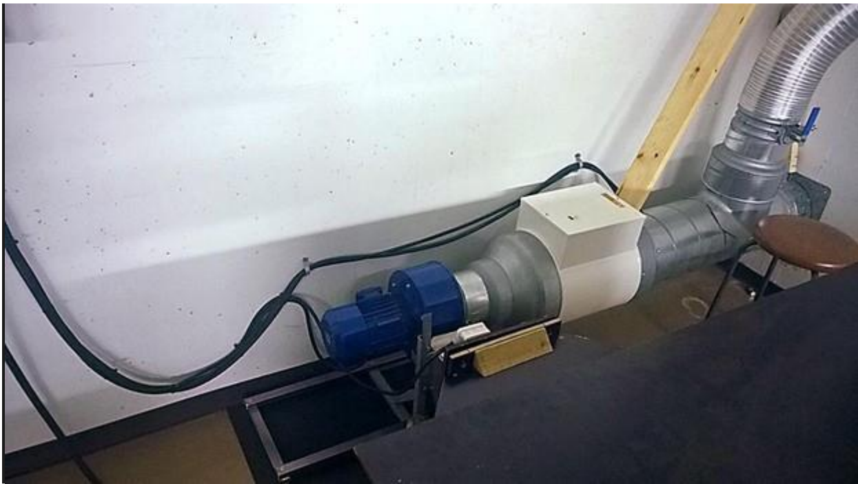
Lähikuvassa kuivurimen puhallin.
