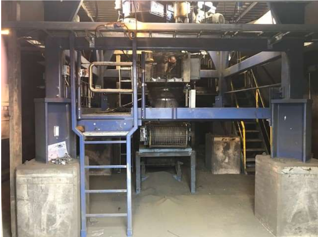
Kuva 22. SI27:n asennettu uusi taso.
