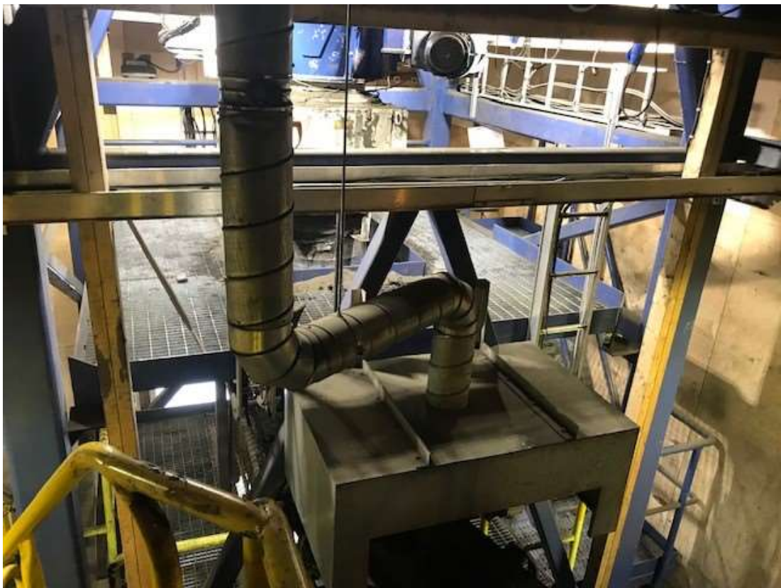
Kuva 23. SI53:n asennettu uusi taso.
