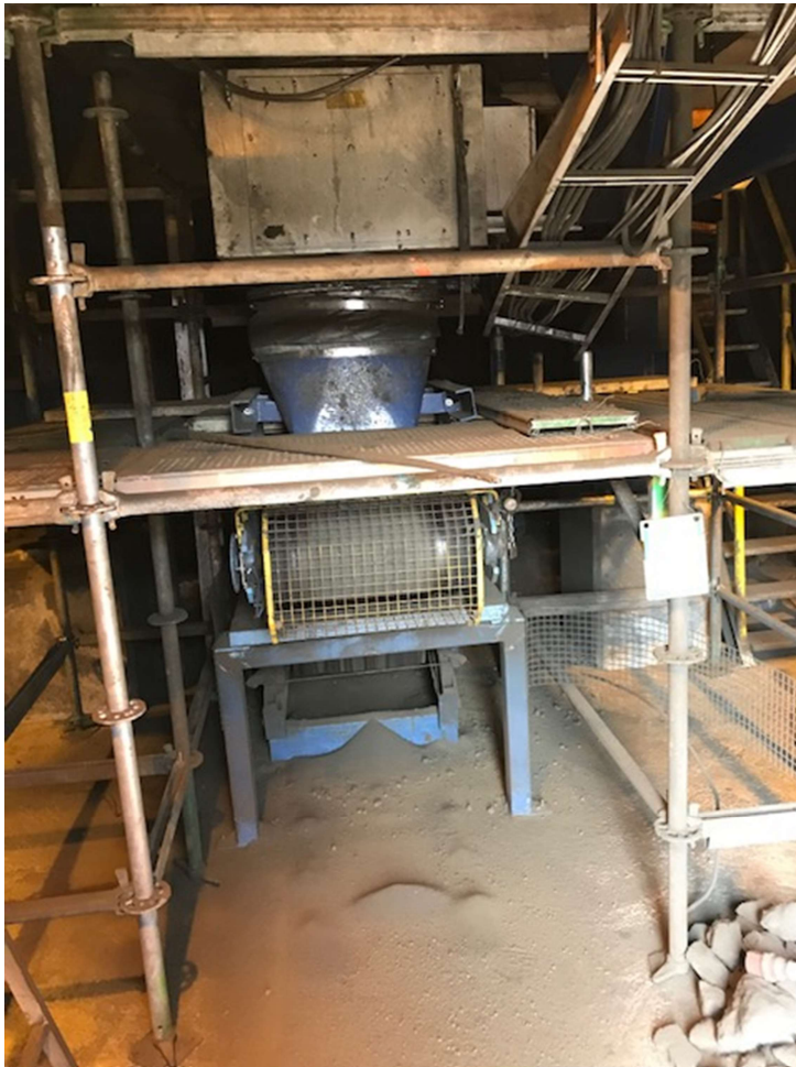
Kuva 5. SI27:n alapuoliset telineet.
